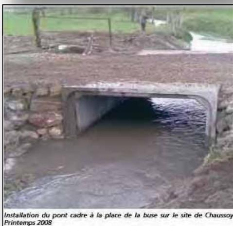
Installation du pont cadre à la place de la buse sur le site de Chaussoy Printemps 2008
