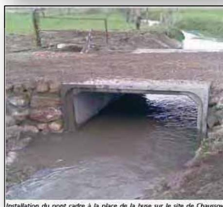
*Installation du pont cadre à la place de la buse sur le site de Chaussoy*
