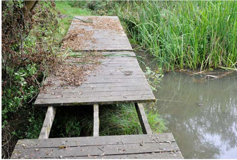
Figure 5. Etat du ponton au niveau de la mare en 2014.
