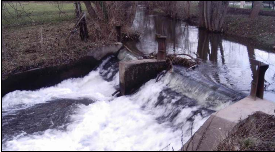
photo. 4 : le seuil infranchissable derrière les établissements Bugatti à Molsheim (photo Ecodève, 2011)
