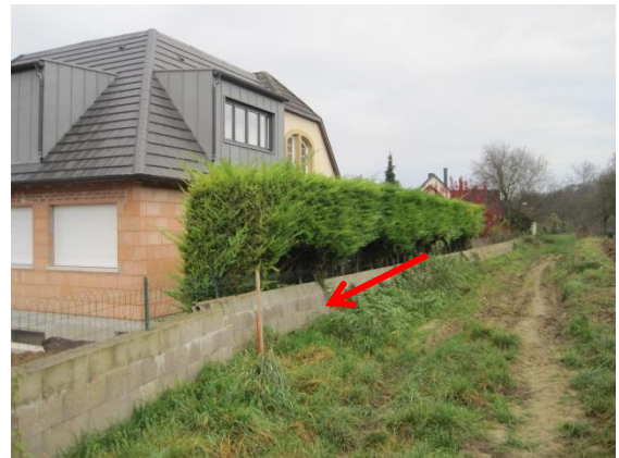
Fig. 14. PHOTOGRAPHIE DE L'AFFAISSEMENT DU MUR DE LA PREMIERE HABITATION
