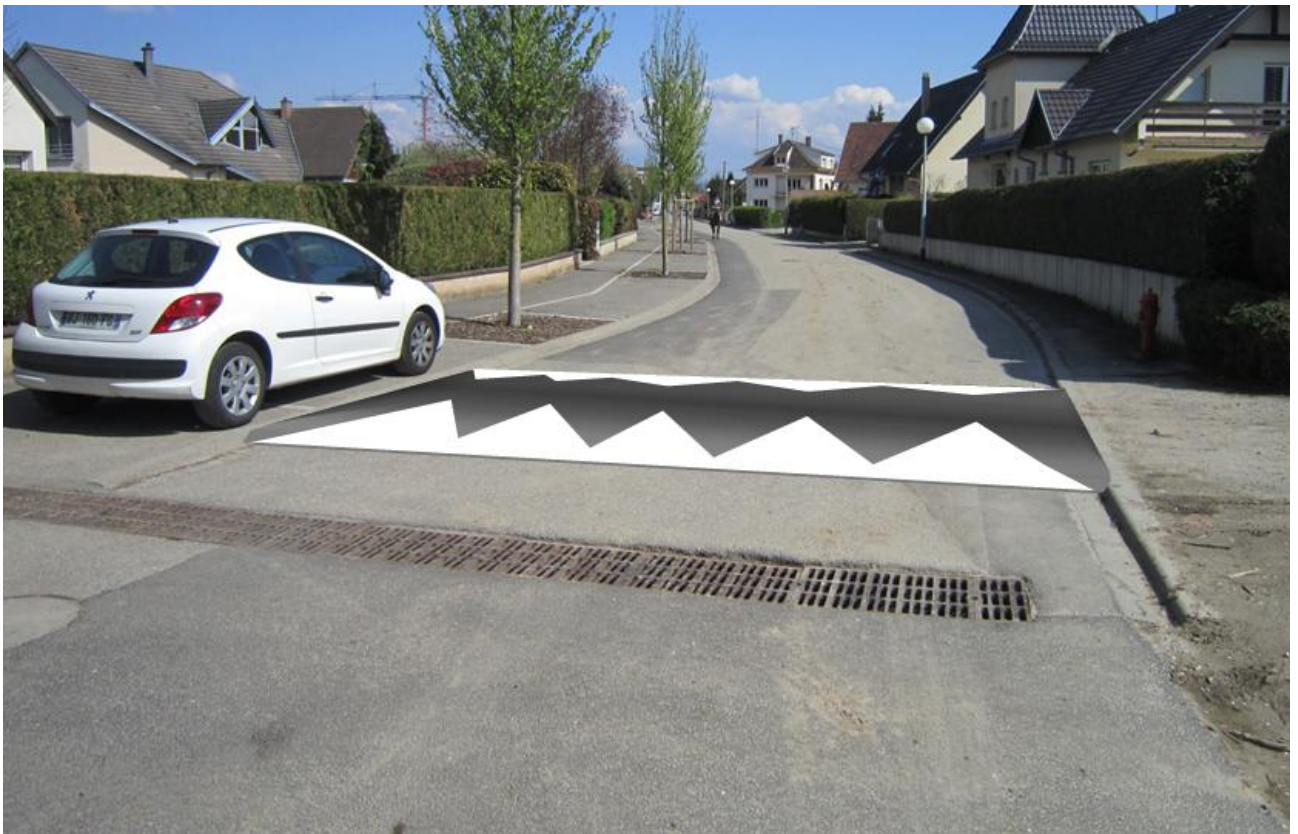
Fig. 20. SCHEMA DE L'IMPLANTATION D'UN DOS D'ANE A L'AVANT DE LA GRILLE SUR LE BV N°1
