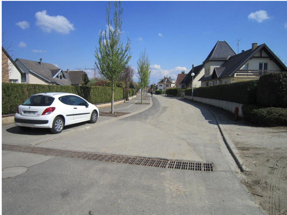
Fig. 10. GRILLE DE RECUPERATION DES ECOULEMENT A L'ENTREE DE LA RUE DU FORT FOCH
