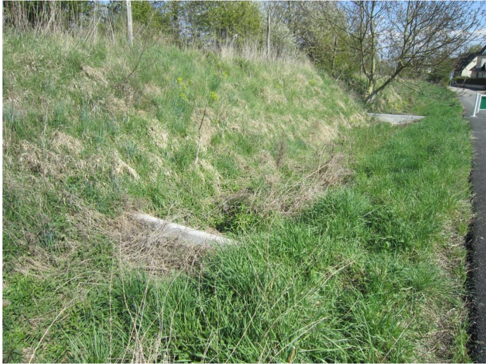
Fig. 8. PHOTOGRAPHIE DES RALENTISSEURS MIS EN PLACE SUR LE CHEMIN MENANT AU FORT
