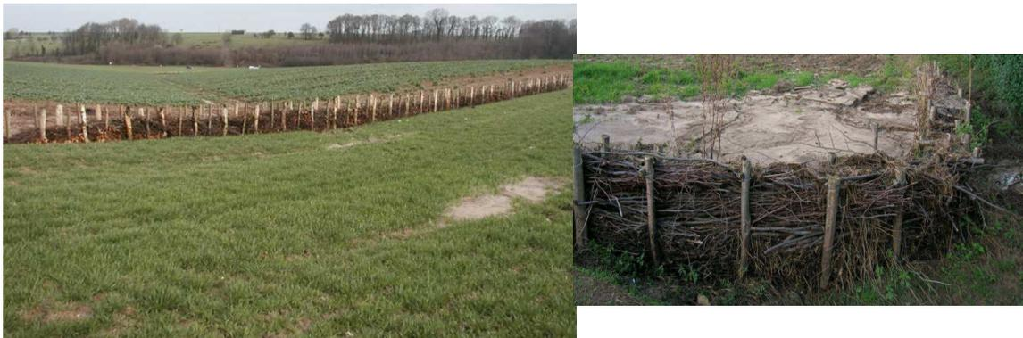
**Barrage gabions :** [*piège à sédiment, frein hydraulique*] gestion des ruissellements concentrés importants et de lutte contre l'érosion concentrée ;
