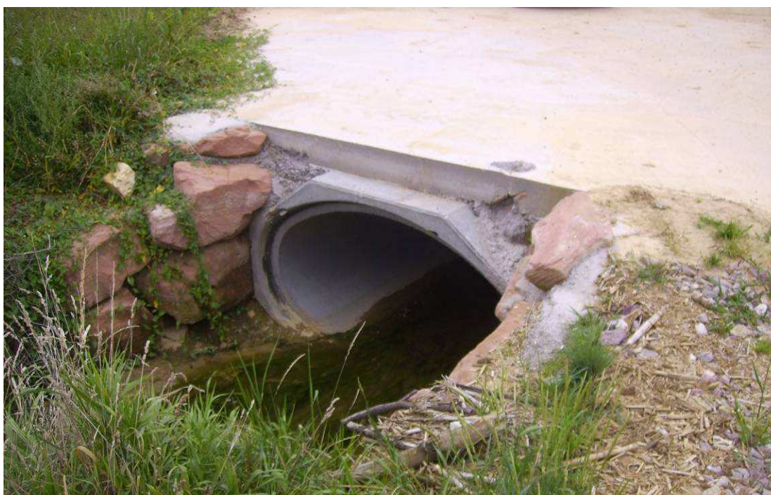
Figure 87: Passage busé réaménagé sur le fossé du Landgraben
