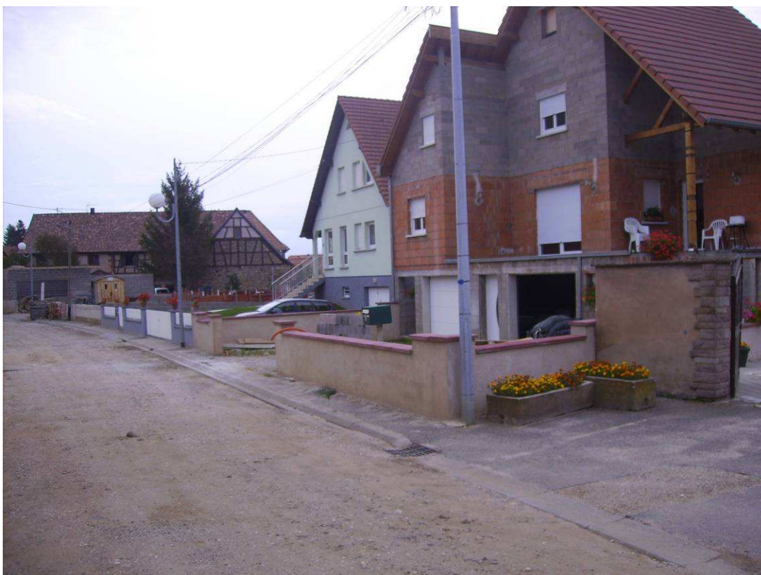
Figure 51: Maisons récentes, construites sur un ancien fossé aujourd'hui comblé. Lors de forts orages, l'eau circule en surface sur son ancien lit et inonde les habitations
