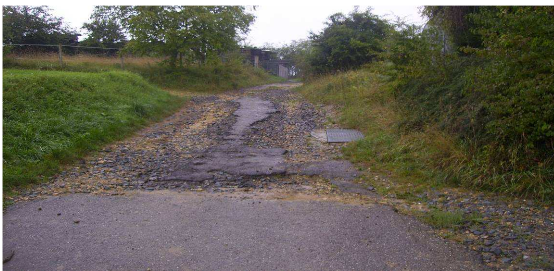
Figure 65: Vue de la sortie du versant agricole de l'unité n°3, le chemin rural dit « Am Ringeldoerfer Weg » faisant office de collecteur
