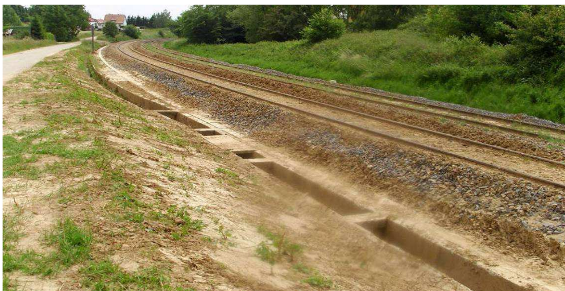
Figure 44: Voie ferrée SNCF touchée par les coulées d'eau boueuse en amont d'Ettendorf (Juillet 2009)
