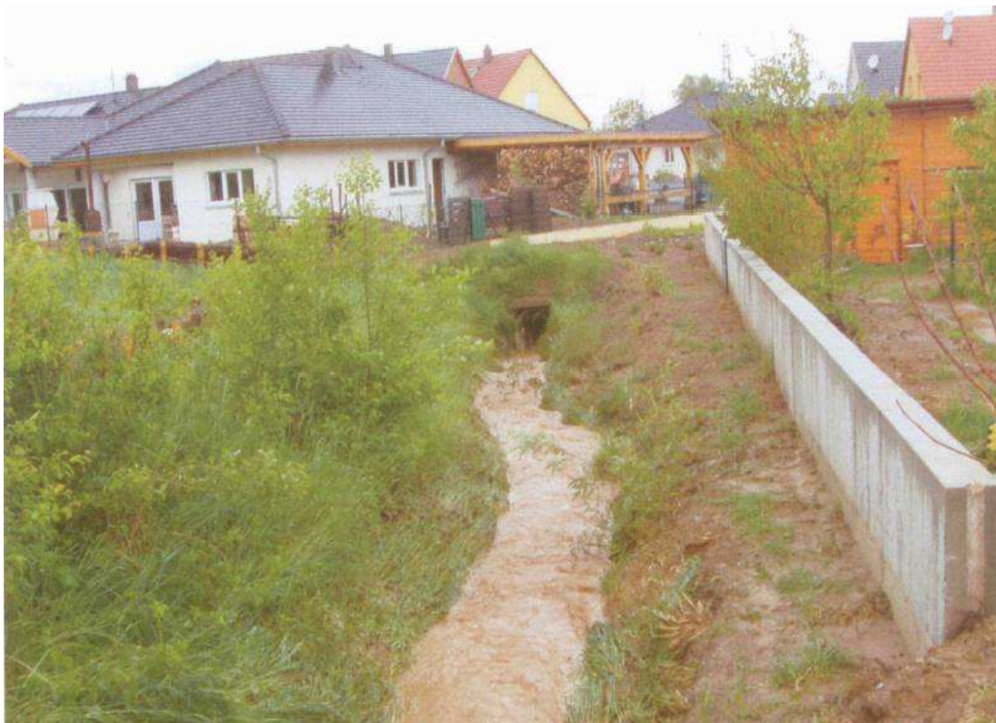
Figure 62: Entrée du passage en souterrain du fossé dit « Steinackengraben », sous le quartier résidentiel situé autour de la rue de Rossignols
