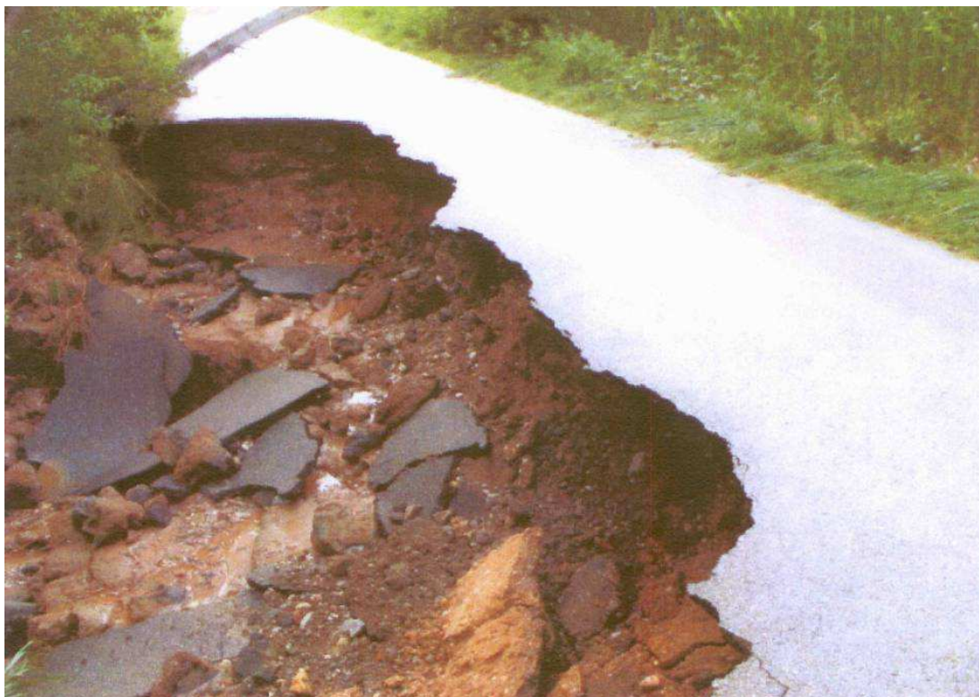
Figure 78: Dégradation de voirie causée par les eaux
