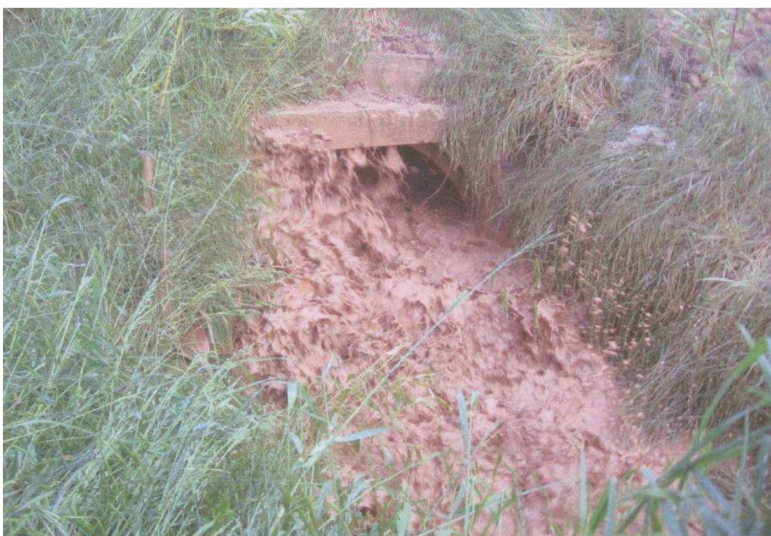
Figure 63: passage en souterrain du fossé dit « Steinackengraben » quasi à saturation
