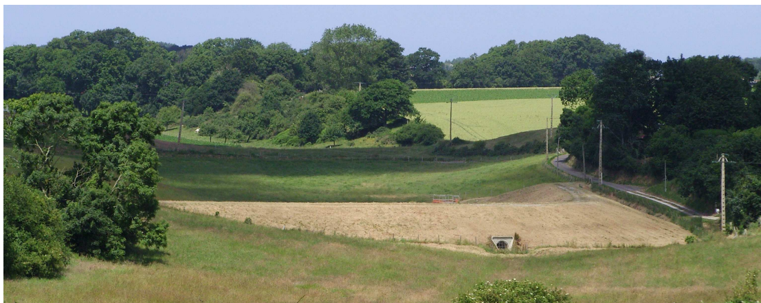
Figure 143: Prairie inondable tout juste achevée, barrant un vallon sec au niveau d'une pâture
