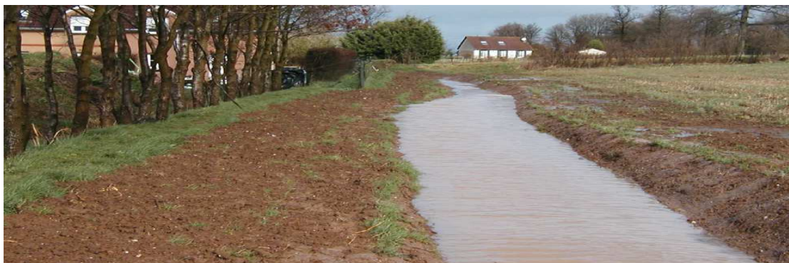
Figure 123: Exemple de fossé de ceinturage, protection rapprochée d'habitations
