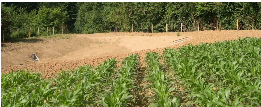
Figure 126 : Exemple de bassin de rétention
