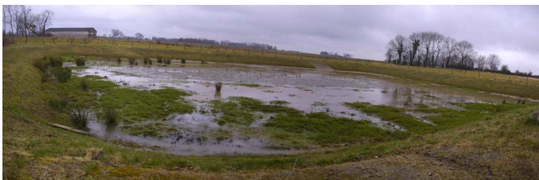
Figure 144: Bassin de rétention sur topographie moins marquée, permettant stockage d'eau important
