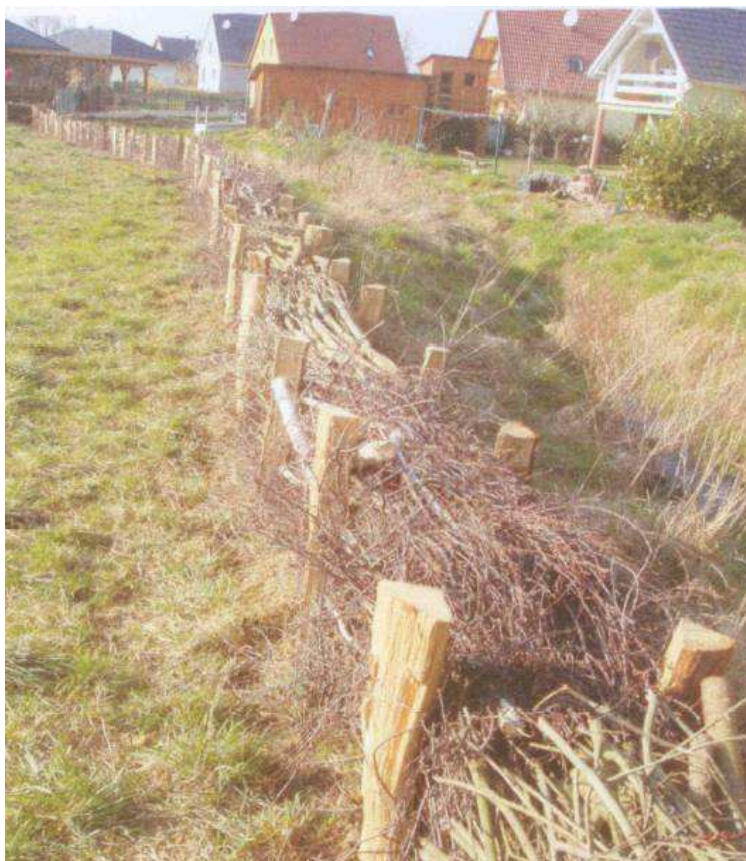
Figure 70: Fascine de bout de champs mis en place pour réduire les arrivées d'eau et de boue en sortie de parcelle
