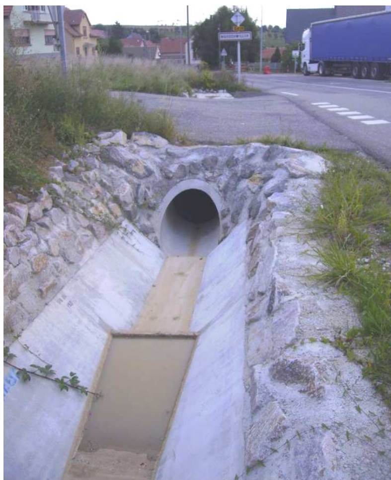
Figure 52: Buse (réaménagée) d'entrée du réseau Eaux Pluviales de Morschwiller, récupérant les eaux du fossé de la D149 et saturée lors de fort orages
