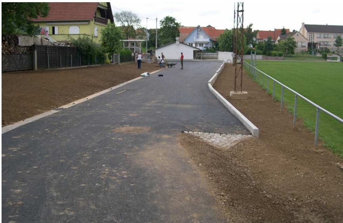
Figure 40: Voirie refaite dans le but de canaliser au mieux les écoulements sur la chaussée
