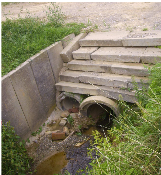
Figure 164: verrou hydraulique en aval de Dauendorf
