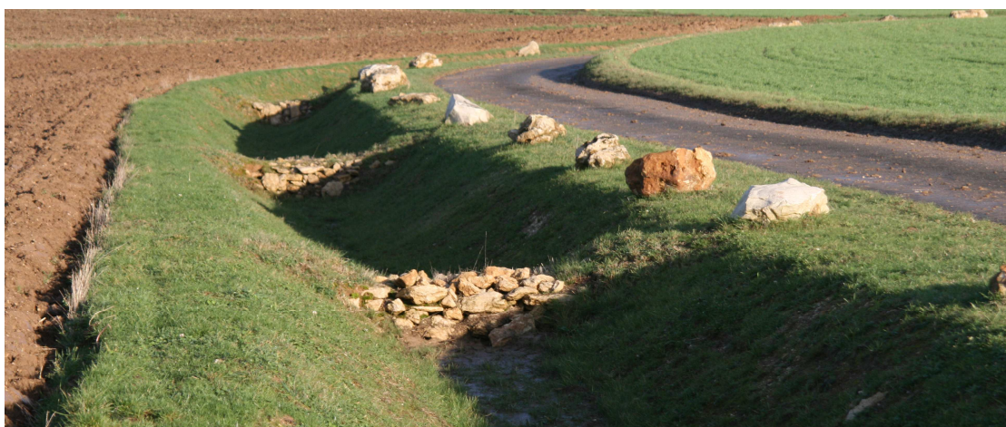
Figure 124 : Exemple d'une noue en bordure de chaussée, en fond de talweg
