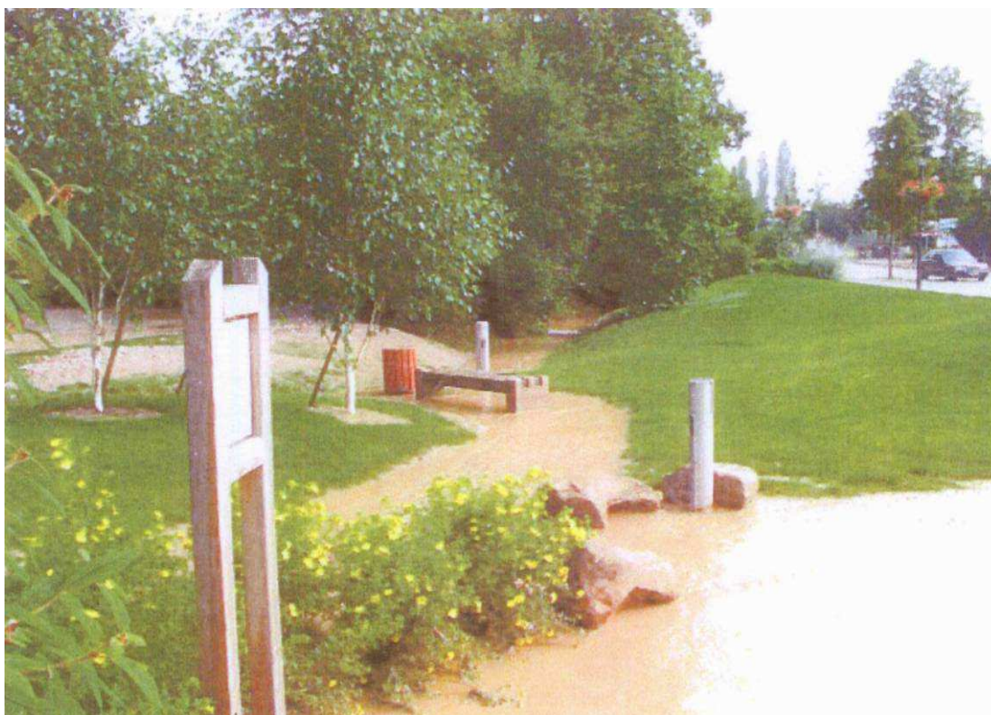
Figure 75 : Inondation du parc municipal près du rond point
