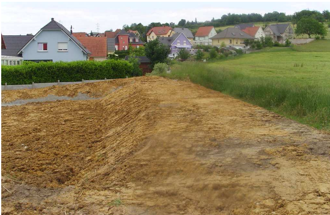
Figure 69: Levée de terre protectrice mise en place en amont immédiat du quartier résidentiel situé autour de la rue de Rossignols
