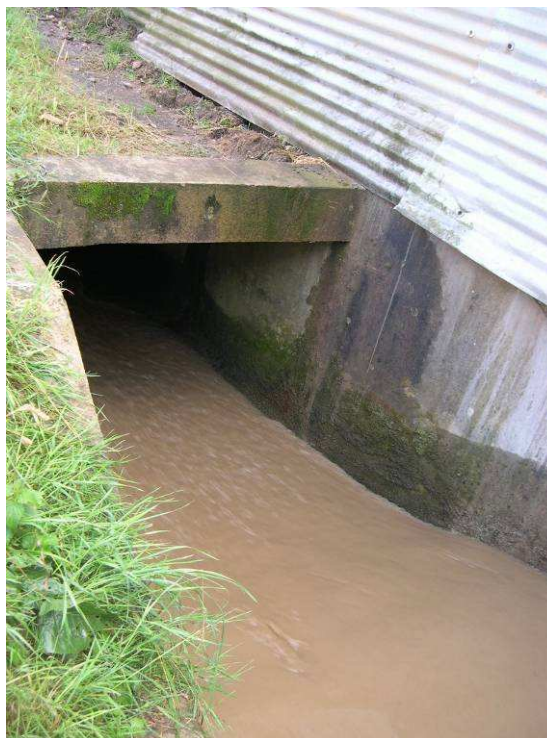
Figure 81: Début du passage en souterrain du ruisseau d'Uhlwiller, sous le village d'Uhlwiller, passage saturé lors de forts orages et provoquant l'inondation de la rue de la Rivière
