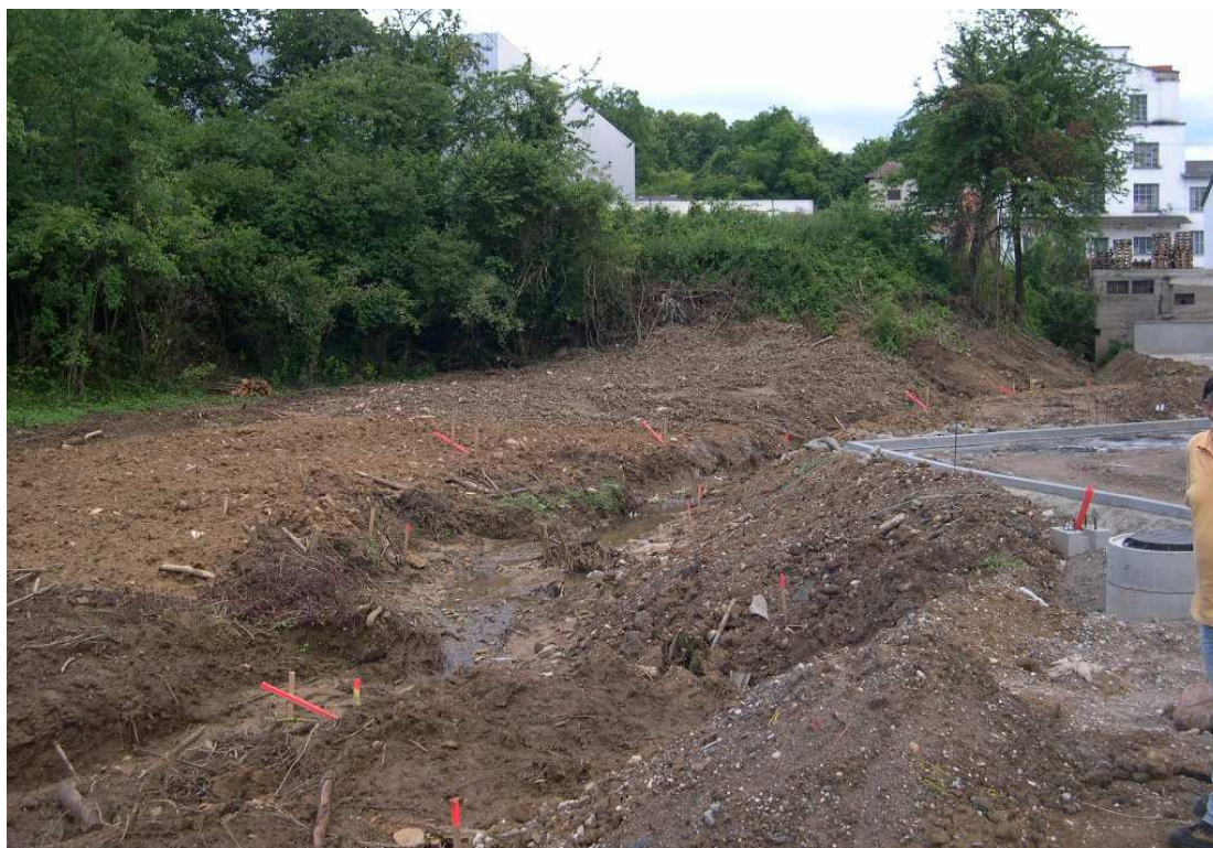
Figure 68: Fossé dit du « Hengstbaechel » contraint à de multiples reprises lors de sa traversée de Pfaffenhoffen (passage en souterrain, sous pont, déviation...) et provoquant plusieurs désordres hydrauliques. Photo prise lors de travaux de construction d'habitations à proximité
