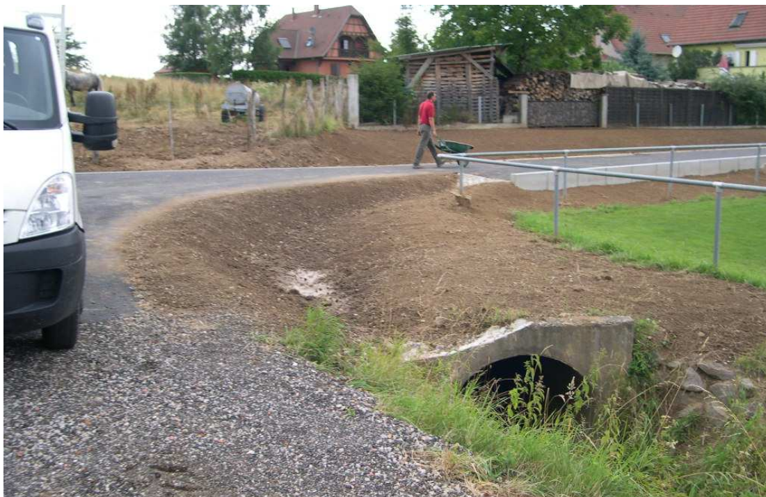
Figure 39: Amélioration des écoulements vers le fossé en sortie de village
