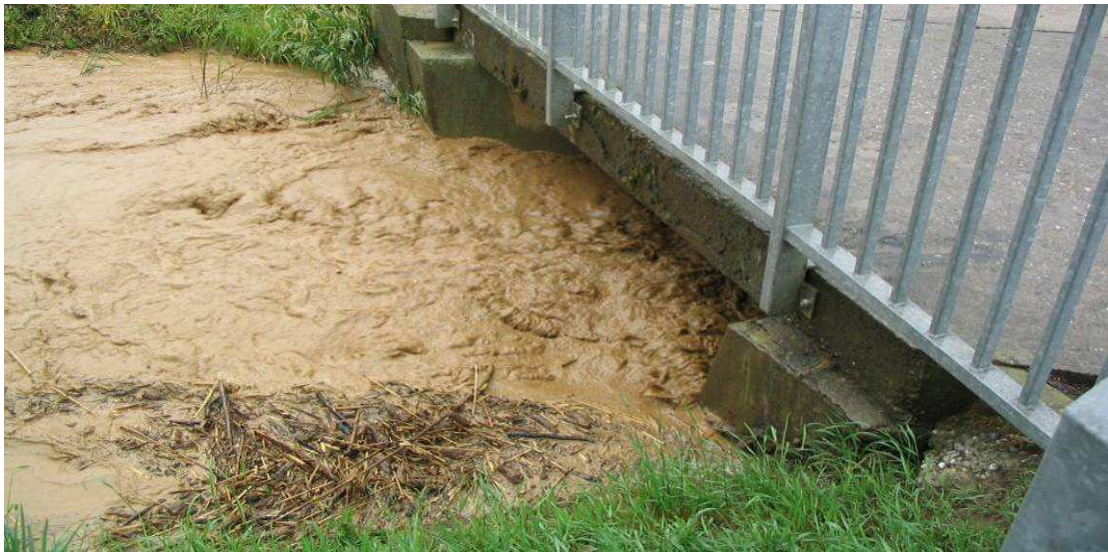
Figure 25: Exemple de saturation de passage sous pont (Uhlwiller, Mai 2009)
