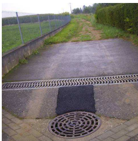
Figure 73: travaux récemment réalisés
