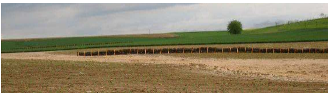
Figure 45: Linéaires de fascines déjà mis en place
