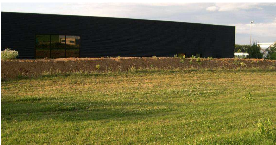
Figure 55: Levée de terre protégeant l'entreprise vulnérable de la ZAC
