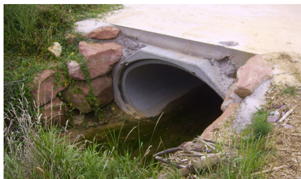
Figure 165 : verrou hydraulique en amont du pont de Niederaltdorf
