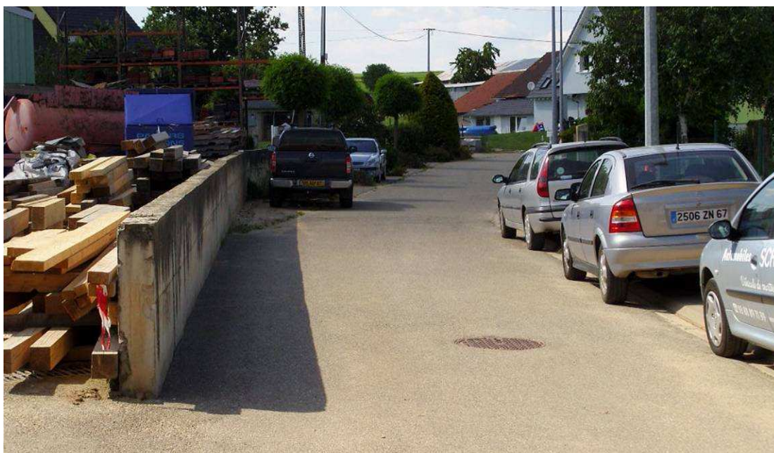
Figure 37; Impasse de la chapelle, inondée à plusieurs reprises
