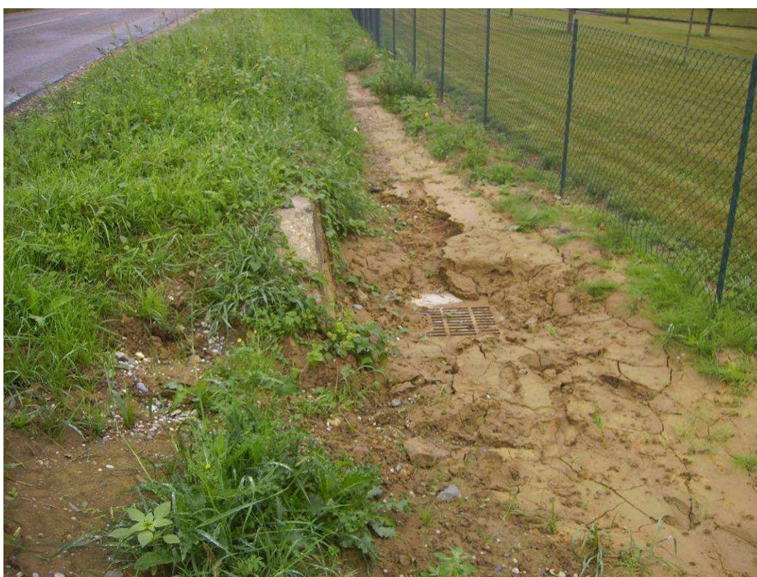
Figure 32: Réseau EP de la route complètement saturé de boue en amont du verger communal
