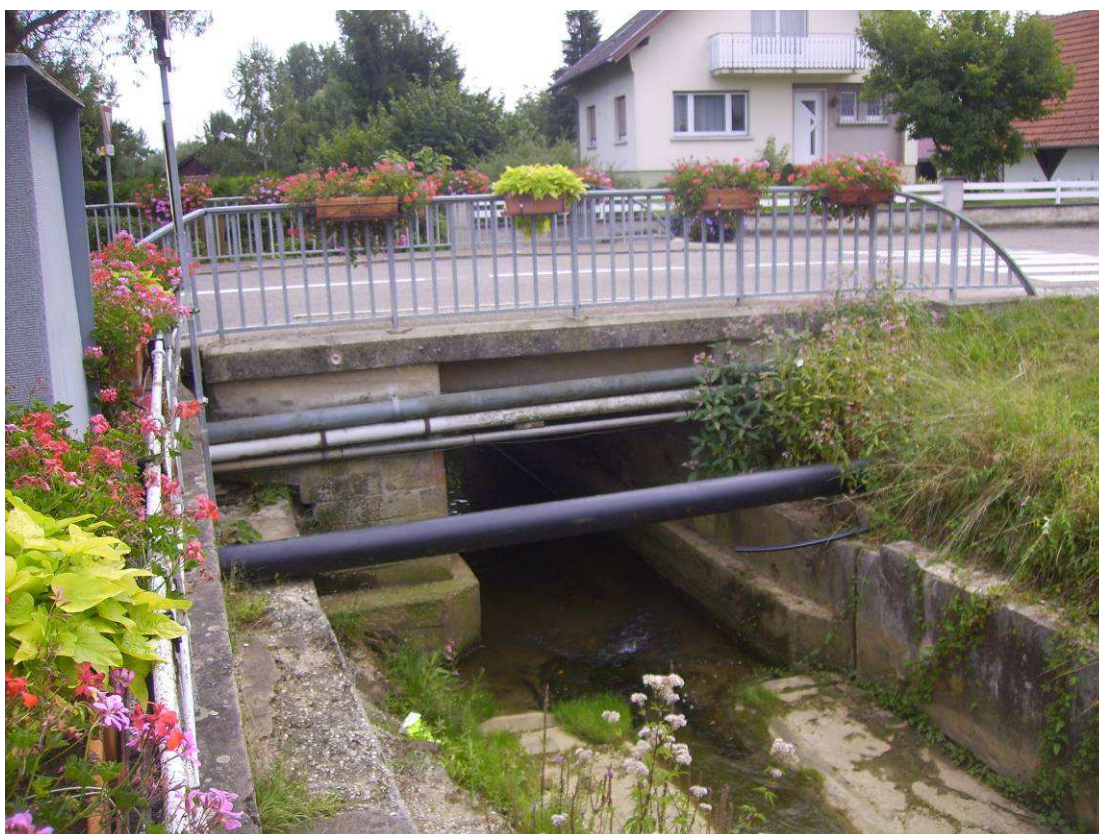
Figure 57: Passage du ruisseau du Jaegerbaechel sous le pont de la D241, dans le village d'Ohlungen, passage saturé lors de forts orages occasionnant des inondations des habitations proches
