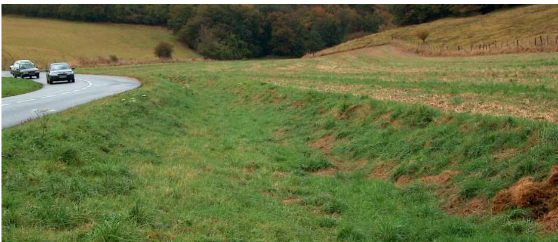
Figure 122 : Exemple d'une noue en bordure de chaussée, en fond de talweg
