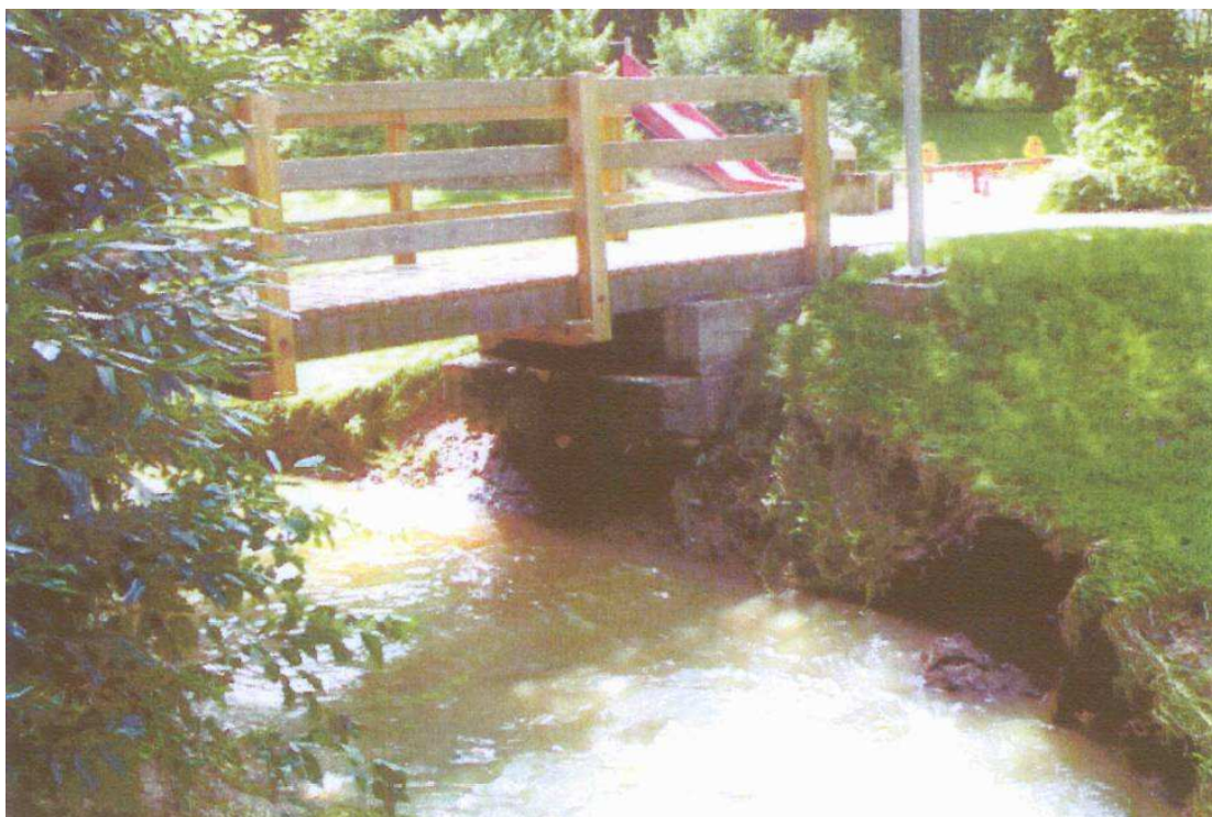
Figure 77: Dégradation d'une passerelle du parc municipal par affouillement basal
