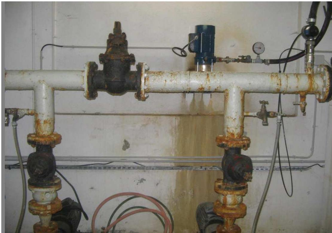
Figure 29 : Point de raccordement sur refoulement des pompes
