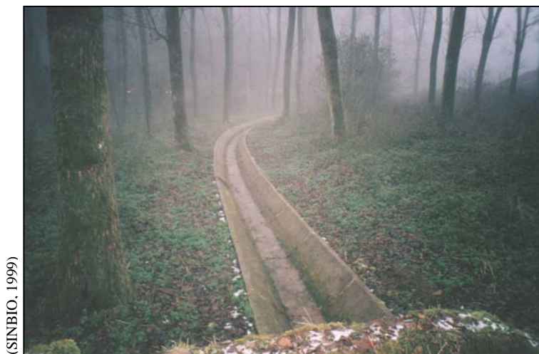
Tronçon 2a Fossé bétonné en sous-bois
