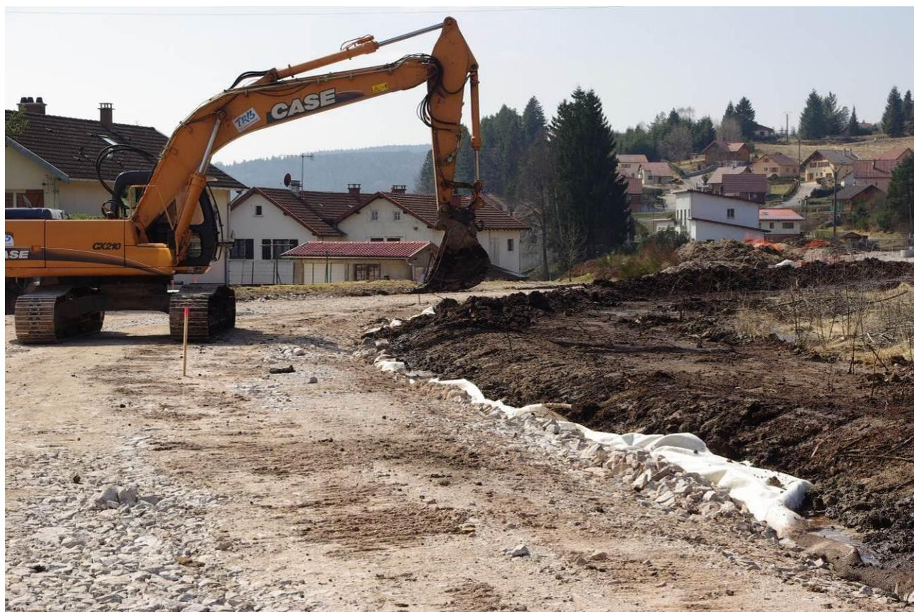
*Travaux d'imperméabilisation de la route par géotextile et de création du merlon, opération conduite en urgence pour la préservation du fonctionnement hydraulique ( cliché 31/09/2009)*
