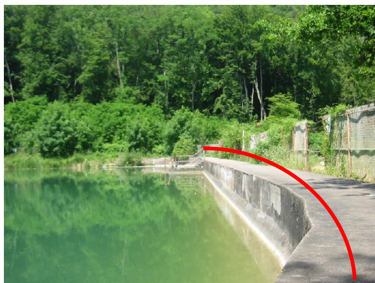
Installation d'un platelage avec rambardes de sécurité sur la digue de l'étang amont.
