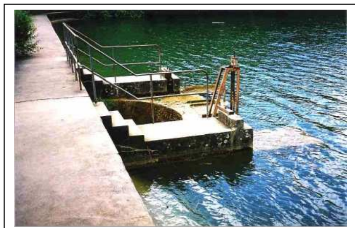
Figure 5 : déversoir de l' Étang amont. Photo Hydrolac
