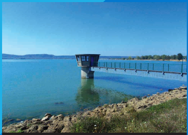
Ouvrage de vidange de fond et son abri de commande à l'extrémité de la digue Lac de Madine
