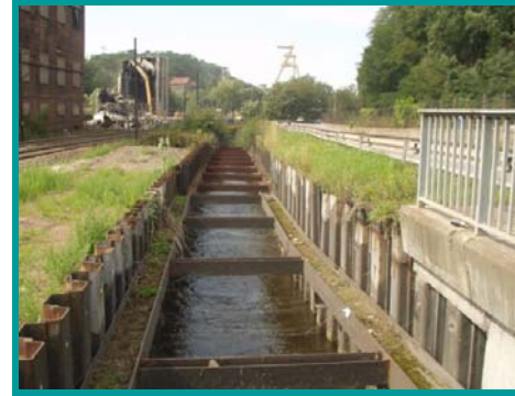
Palplanches le long du Merle Photo SOGREAH, 2009
