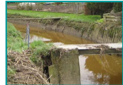
Berges de la Rosselle fortement dénaturées Photo SOGREAH, 2008
