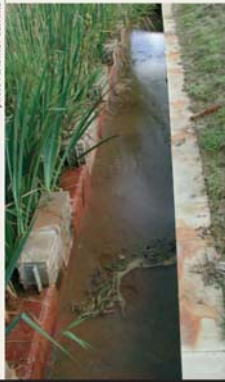
Rigole de recueil des eaux filtrées dans les lagunes plantées de roseaux.
