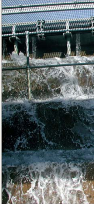
Cascade d'oxygénation des eaux de mine.
