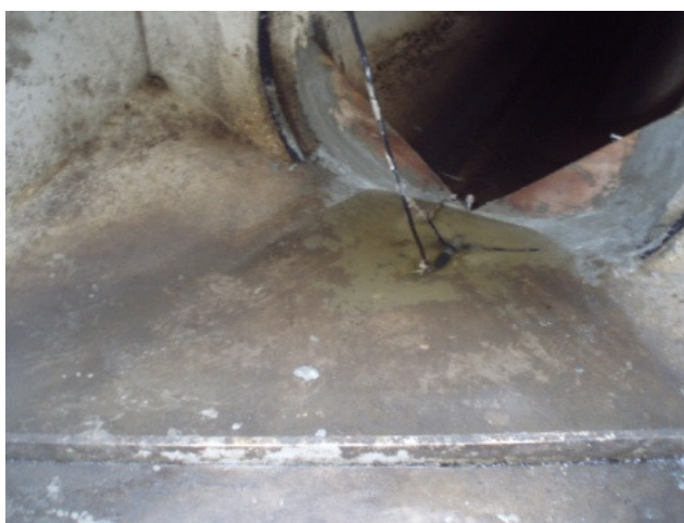
Figure 4 : Photo du déversoir d'orage « Vieux Village »
