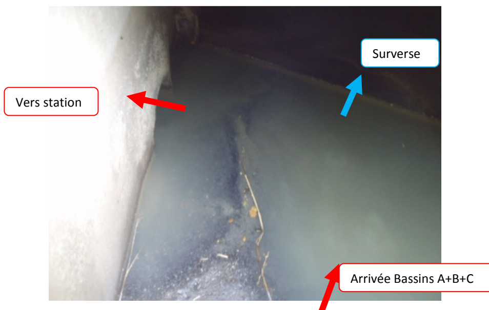
Figure 3 : Photo du déversoir d'orage « Jolivet »
