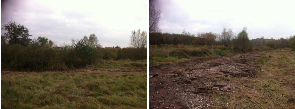
Illustrations des travaux en rive droite (photographies – Christelle Soulas – Sinbio)
