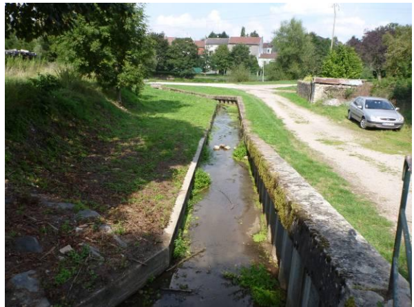
Figure 12 : batardeau de décharge et rigole de délestage vers le chenal de crue
