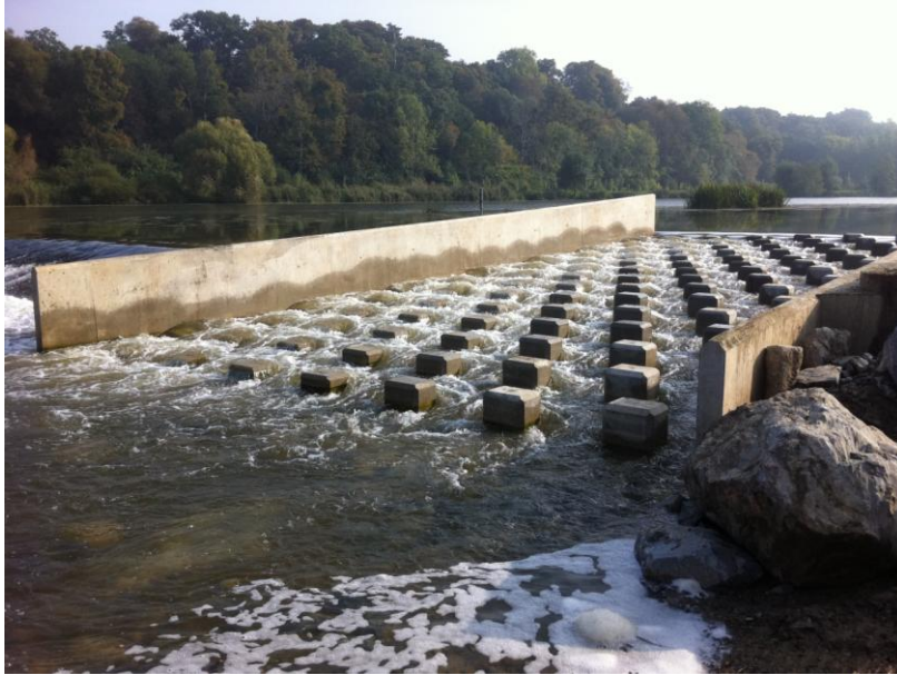
Figure 36 : passe à poissons à blocs régulièrement répartis de Juigné-sur-Sarthe (72)
