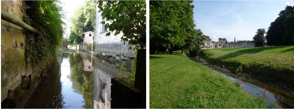
Figure 14 : le canal de fuite en aval immédiat du moulin et dans le parc du Château
