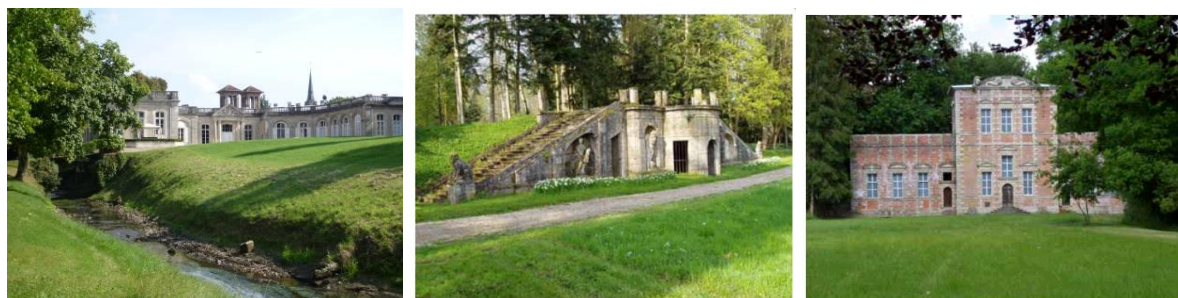
Figure 28 : photos du Château, de la Nymphée et du Pavillon rouge
