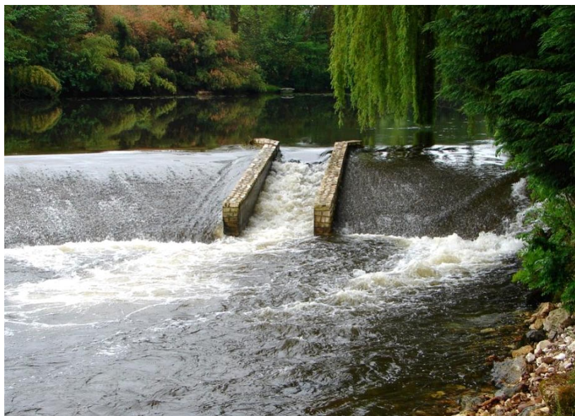
Figure 33 : Glissière à canoë aménagée sur un seuil déversoir
