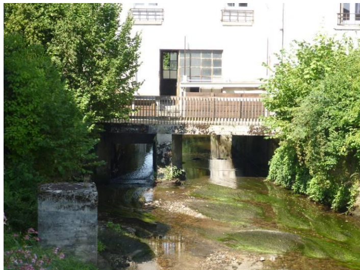
Figure 4 : vue du moulin
