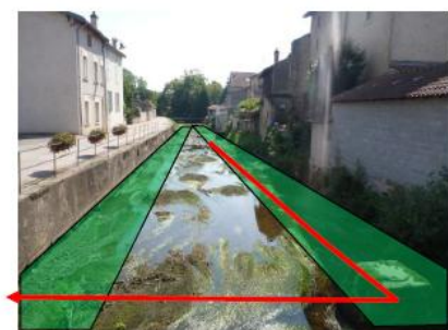
Remplacement de la conduite d'assainissement (en rouge) et implantation des banquettes (vert)
