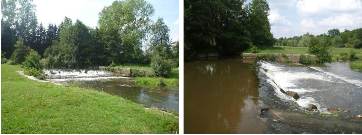
Figure 2 : vue du seuil déversoir amont
