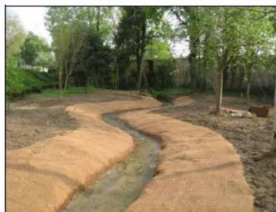
Aménagement du ruisseau de Montvaux sur le site de l'Agence de l'Eau Rhin Meuse en Moselle (57)
