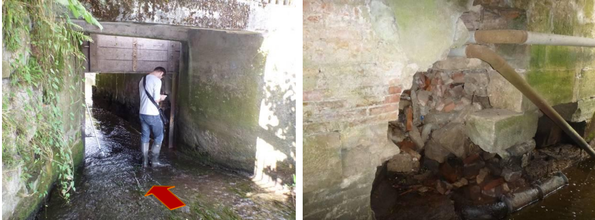
Figure 6 : vue du vannage de gauche et de la dégradation du mur latéral (depuis l'amont)
