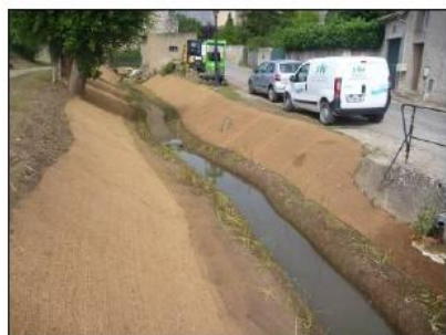
Aménagement du ruisseau de Faulbach à Rodemack (57), village médiéval classé aux monuments de France
