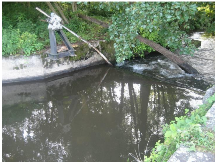
Figure 3 : vue de la vanne à clapet
