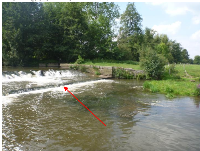
Figure 27 : ressaut présentant un danger important
