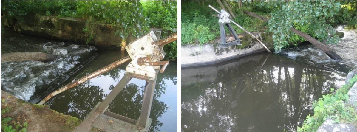
Figure 9 : seuil à clapet en position haute
