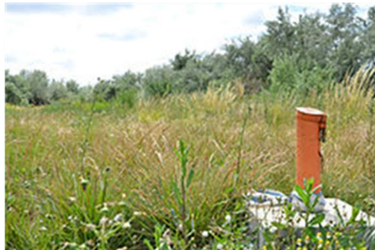
Figure 13 : Piézomètre dans une friche industrielle (Source: Wikipedia)
