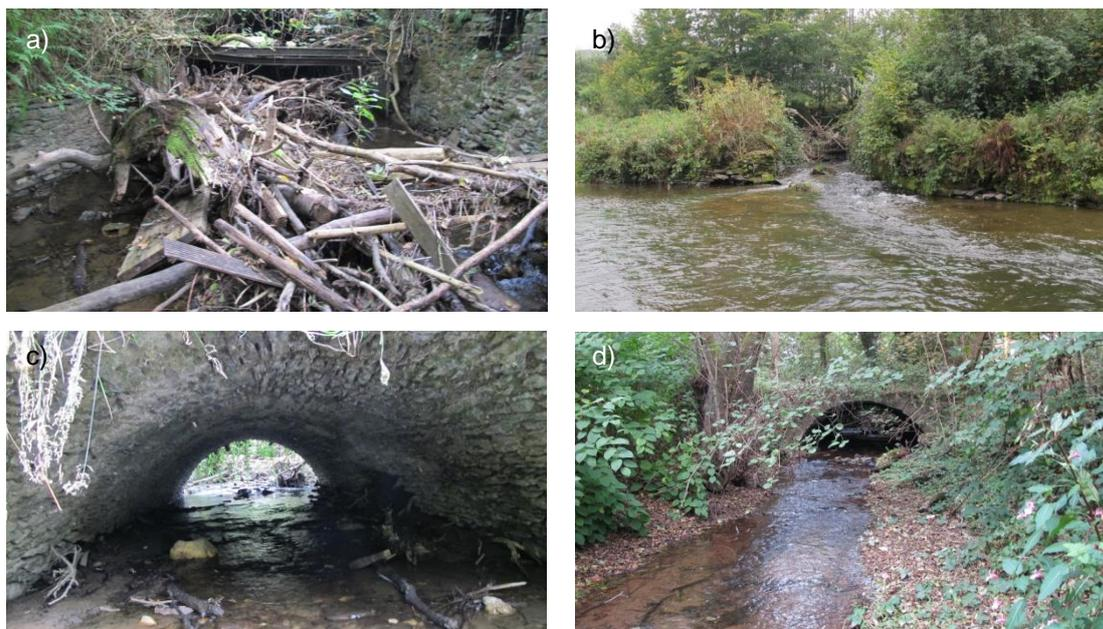
Figure 3-33 : Détail du site de Navaux : a) Embâcles et accumulation de débris ; b) Sortie de l'ancien déversoir latéral ; c) Tronçon vouté ; d) Partie terminal du bras du moulin
