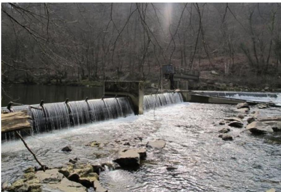
*Figure 2-32 : Le barrage de Phades avec ses vannes mobiles.*
