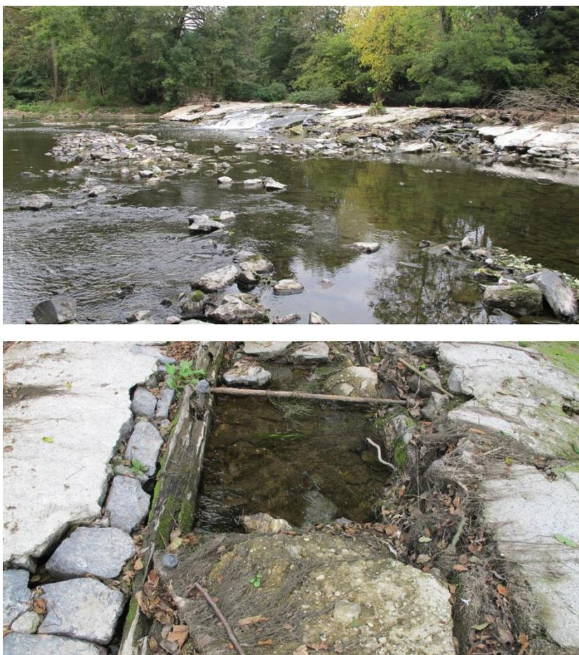
*Figure 3-2 : Déversoir de la racine - Vue d'ensemble rive droite (en haut) et détail de sa composition hétéroclite (en bas)*
