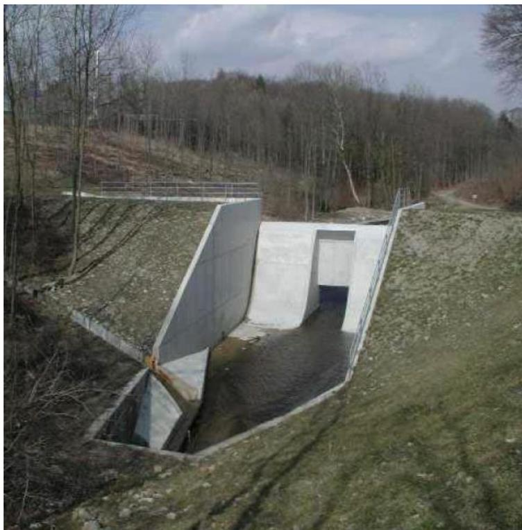
Figure 3-48 : Exemple d'un système de vidange fixe avec mise en charge lors des crues
