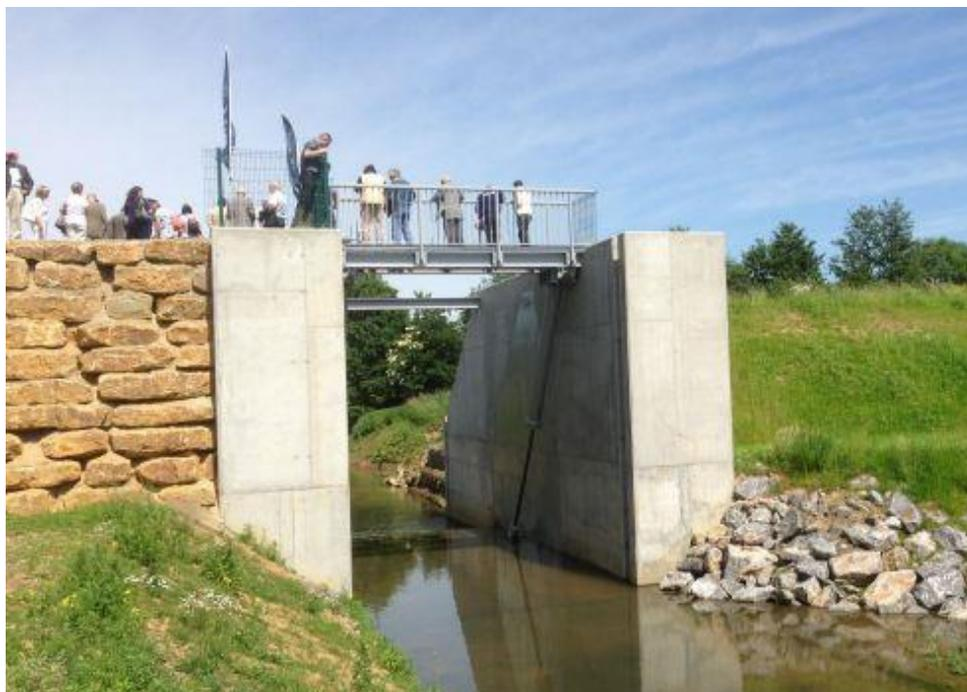
*Figure 3-49 : Ouvrage de vidange avec système de régulation par vanne clapet amovible*
