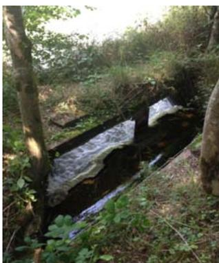
Surverse du canal au dessus de palplanches métalliques avant de confluer avec la Meuse
