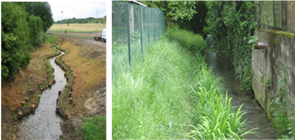
Fig. 14. Exemple de réalisation de lit mineur d'étiage (Marange-Silvange 2007 et Vendenheim 2007 / ARTELIA)
