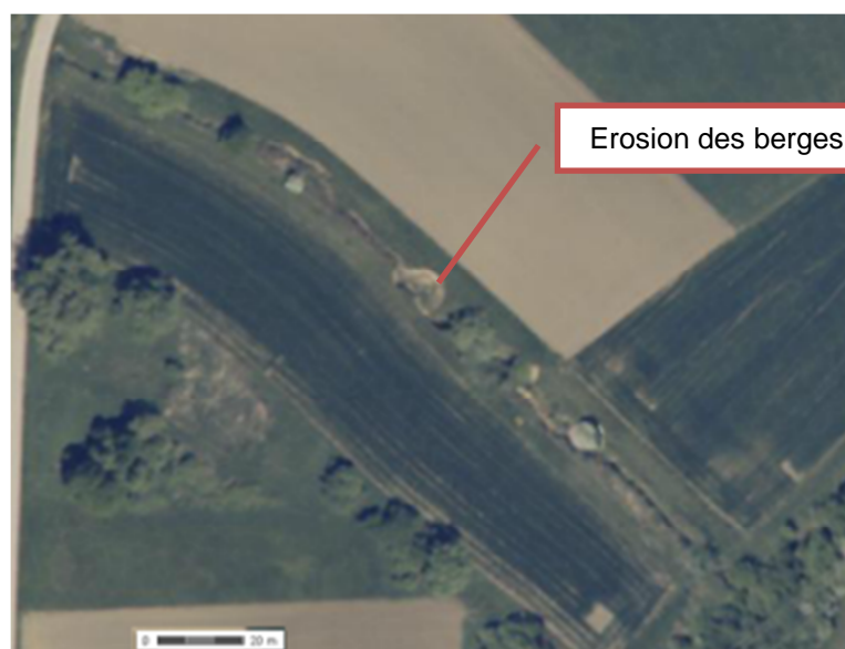
Fig. 7. Vue aérienne de l'érosion de berge
