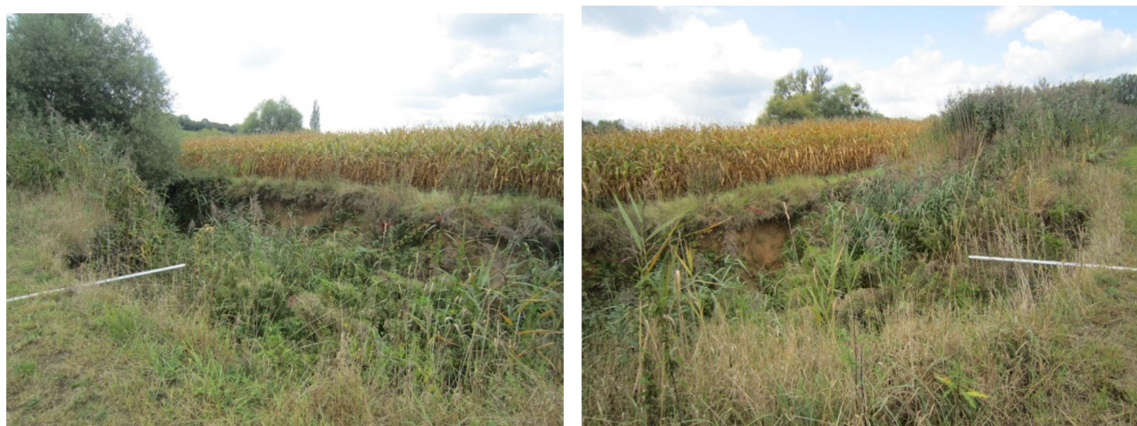
Fig. 8. Photos de l'érosion de berges (vue vers l'amont et l'aval - Septembre 2012)
