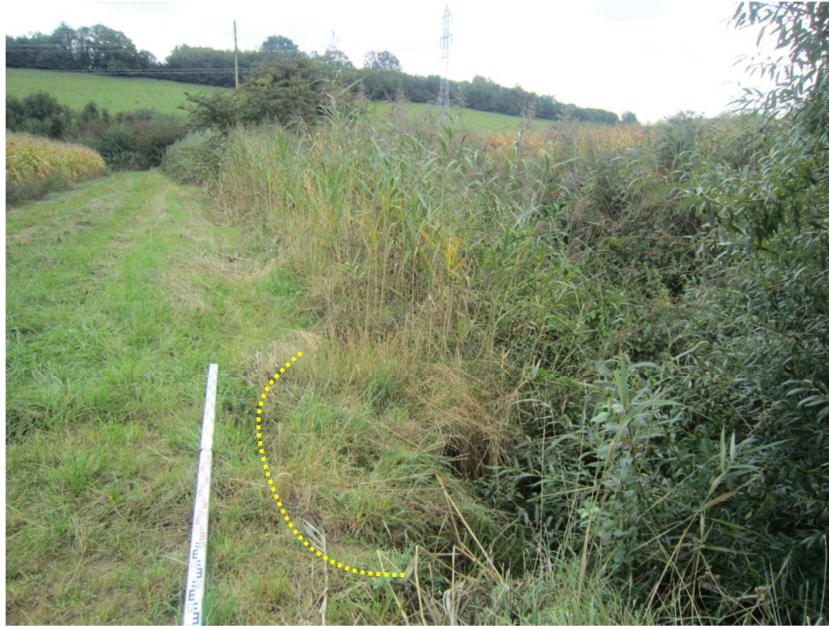
Fig. 9. Glissement de la berge en rive gauche à l'aval de l'érosion (Septembre 2012)
