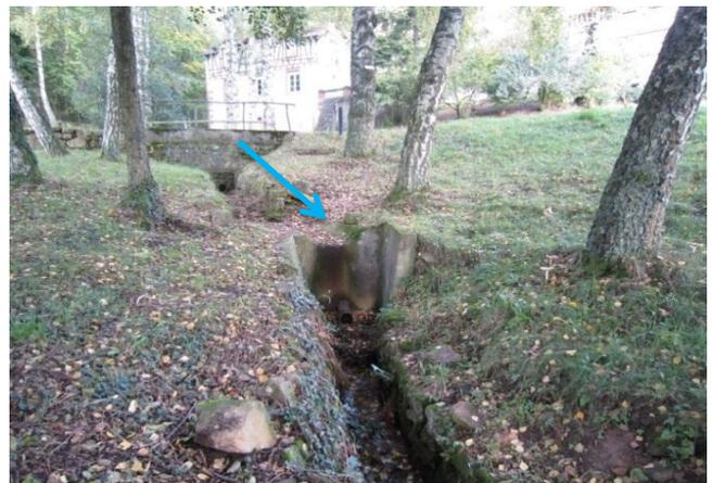
En aval de l'ouvrage de franchissement : présence d'un seuil de 1.2m
