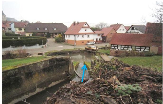
Seuil de Preuschdorf - Dépôt de sédiments en amont de l'ouvrage
