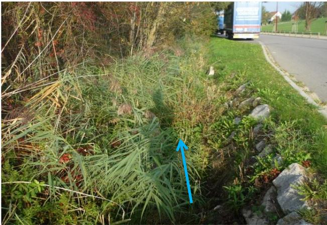
végétation envahissante - enrochement en rive droite à la sortie de la buse
