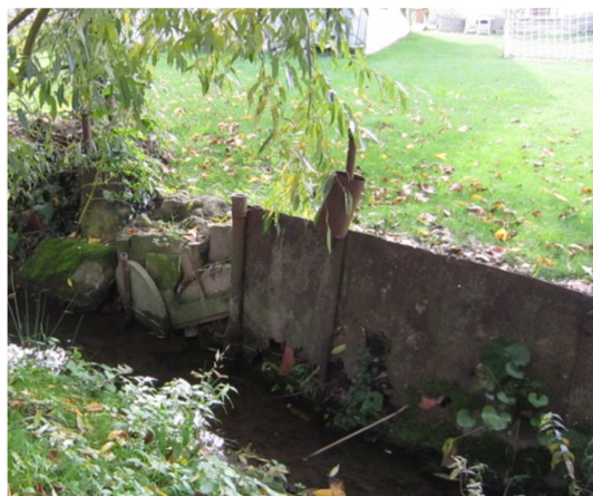
Fig. 3. Exemple de protection de berge sommaire à Lobsann
