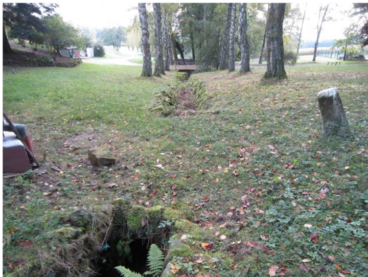
Photo 11 : Passage busé sur le Marienbaechel amont
