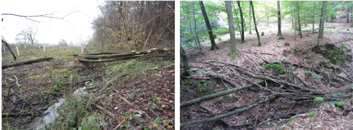
Photo 2 : Embâcles observés sur le Kinderslochgraben amont et sur le Marienbaechel amont
