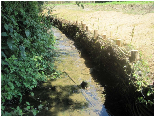
Photo 6 : La Zinsel du Sud (57) après les travaux
