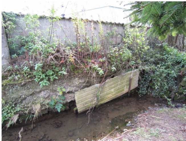
Photo 10 : Mur déstabilisé sur Lobsann
