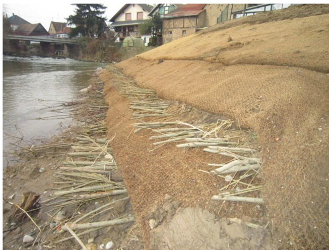
Photo 7 : La Zorn à Weyersheim (67) après les travaux
