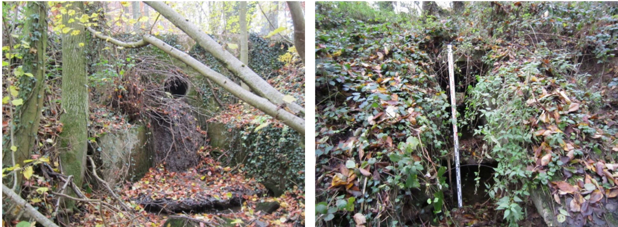
Photo 12 : Ouvrage de franchissement sur le Marienbaechel et le Bettenbach
