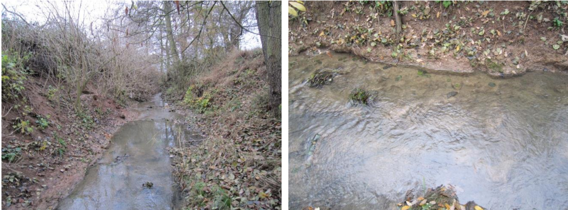
Fig. 20. Apparition du substratum rocheux sur le Seltzbach intermédiaire – berges hautes
