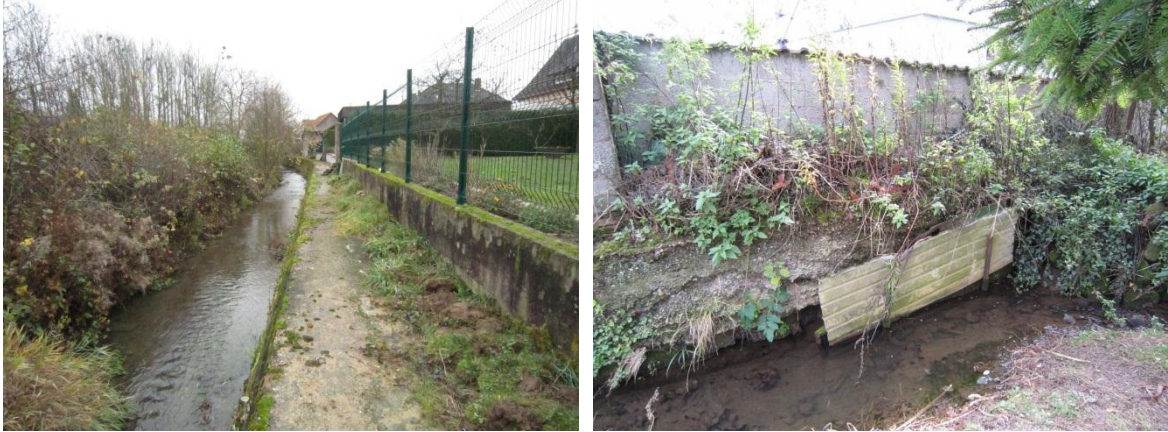
Fig. 22. Berges bloquées bétonnées dans la traversée de Merwiller-Pechelbronn et sur la commune de Lobsann
