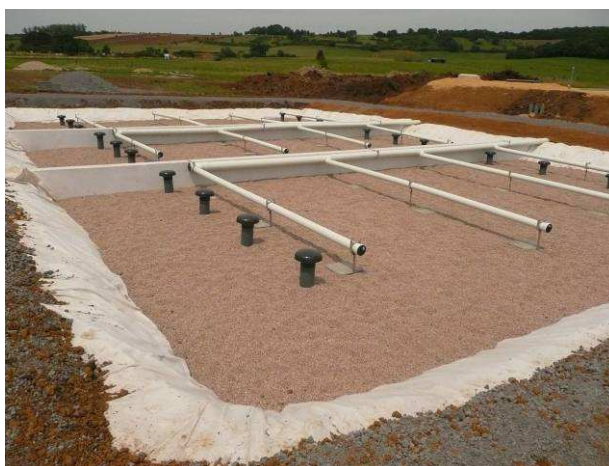
Photographie 9 : Filtre planté de roseaux de la STEP de Chicourt lors de sa construction en août 2011
