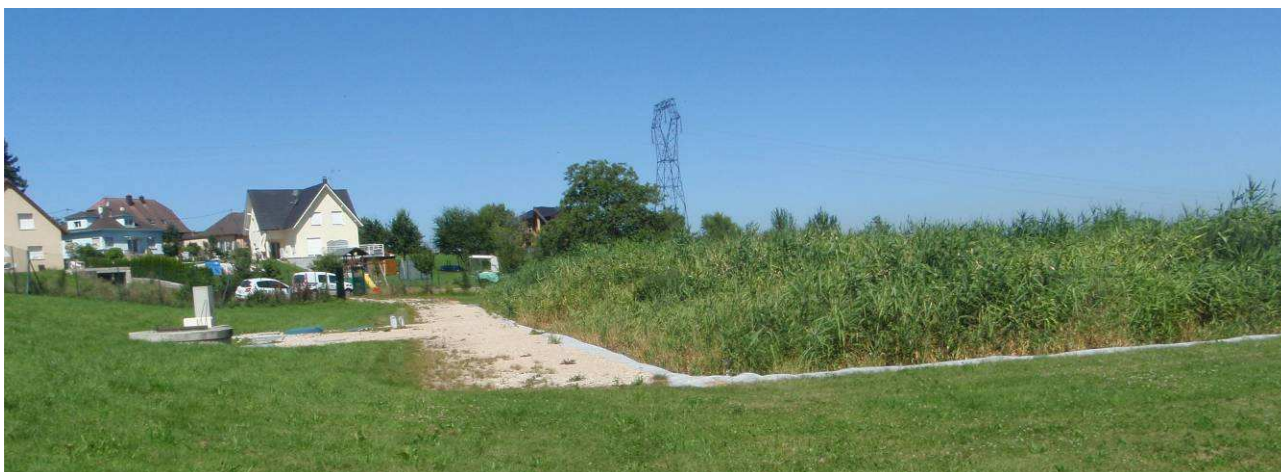
Photographie 8 : Filtre du premier étage de la station d'épuration de la commune de Liebsdorf
