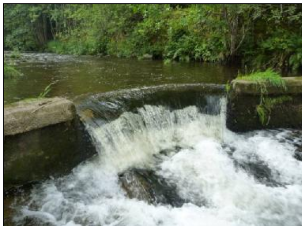
Seuil amont avec large échancrure (chute 70 cm)
