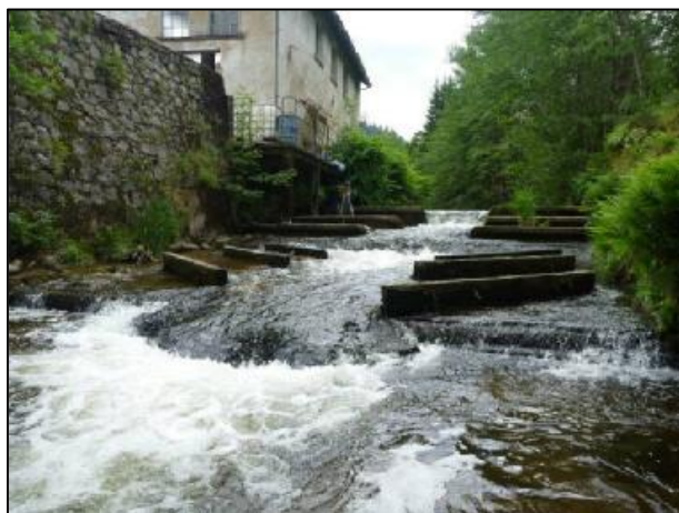
Seuil amont avec large échancrure (chute 70 cm)
