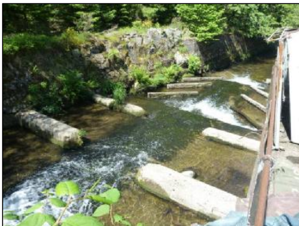
Coursier bétonné et épis latéraux
