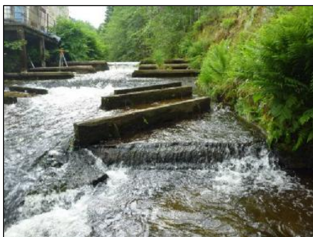
Partie gauche de l'ouvrage
