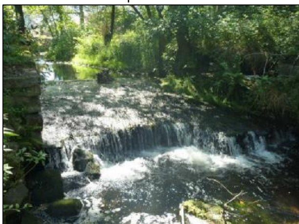
Vue depuis l'aval
