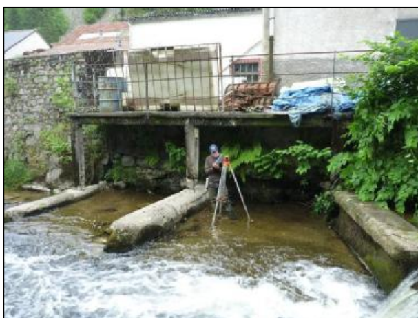
Partie droite de l'ouvrage
