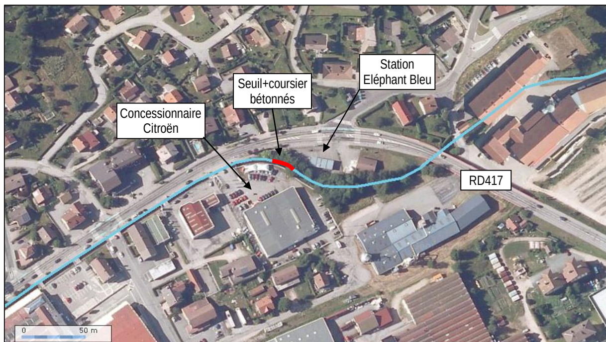
Situation du seuil sur la Jamagne dans la traversée de Gérardmer (source : Geoportail.fr)
