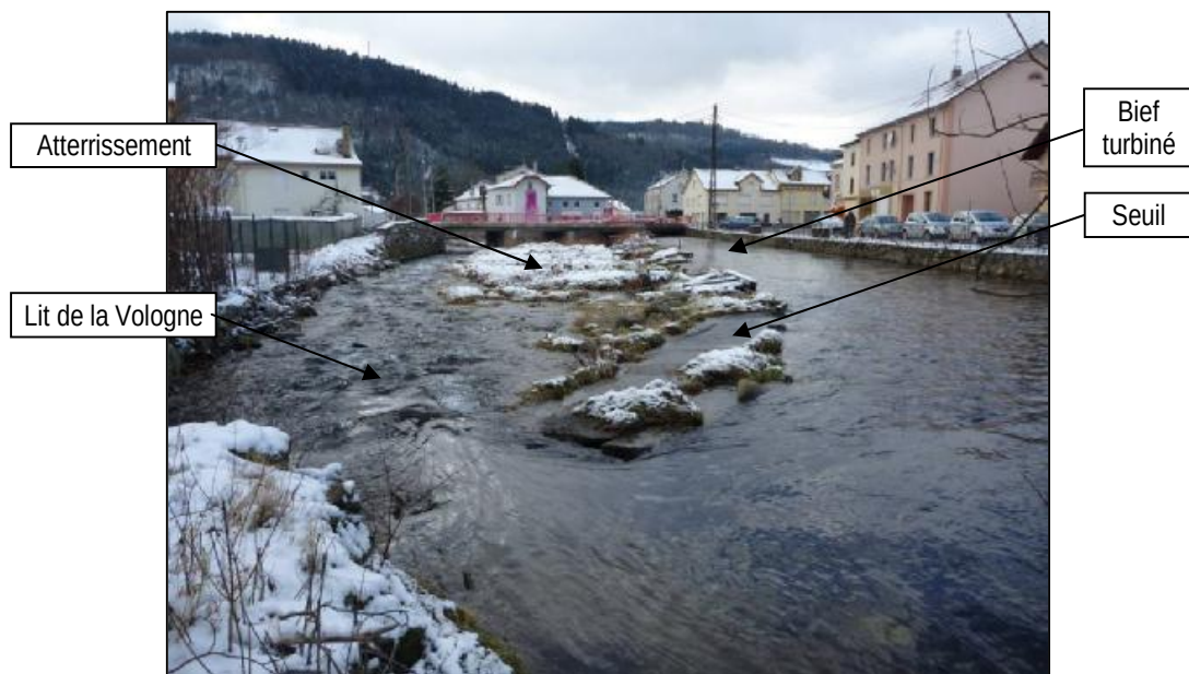
Vue générale du site en janvier 2011 (photo prise depuis l'amont vers l'aval)
