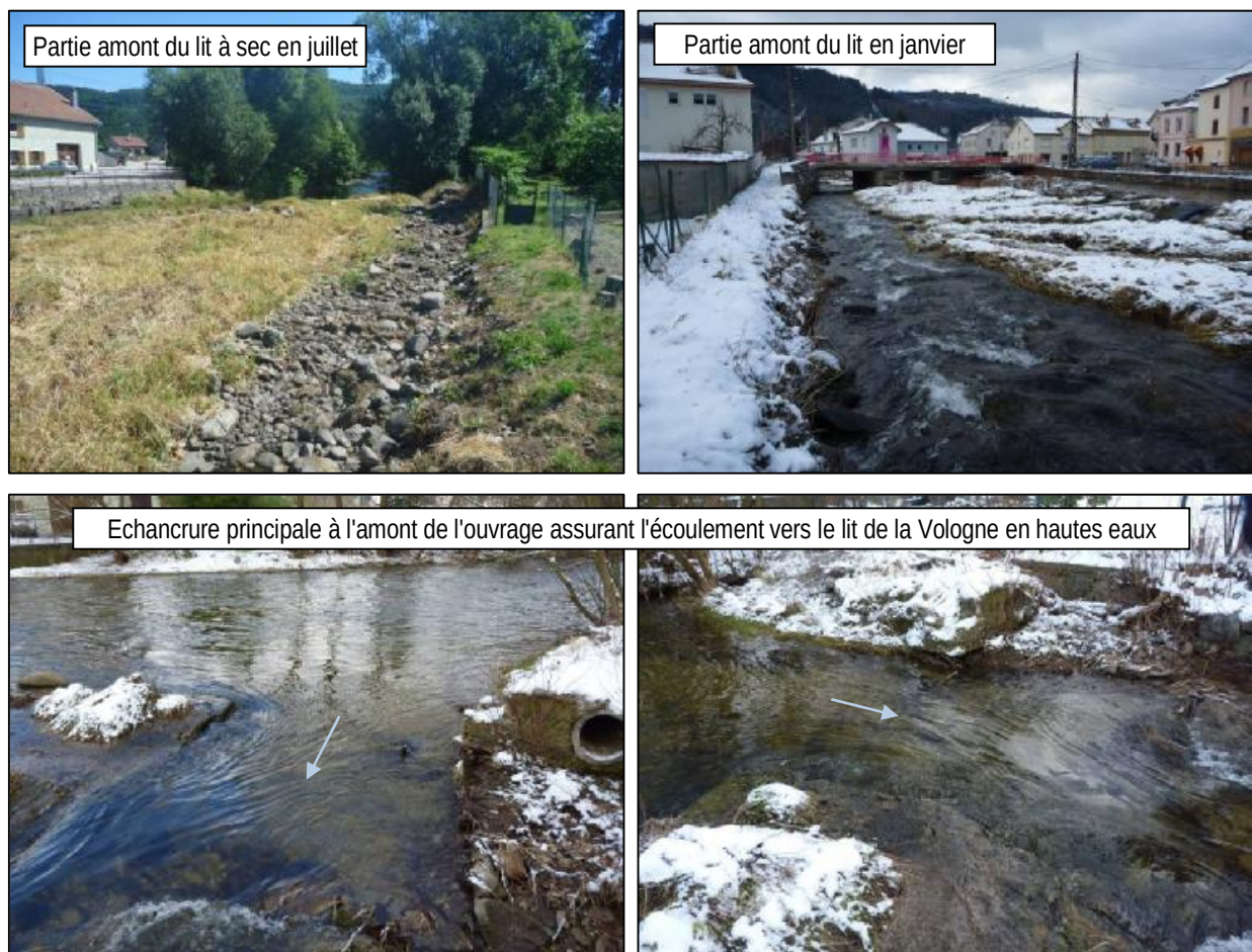
Partie amont du seuil / Lit de la Vologne / Echancrure principale assurant l'écoulement en hautes eaux
