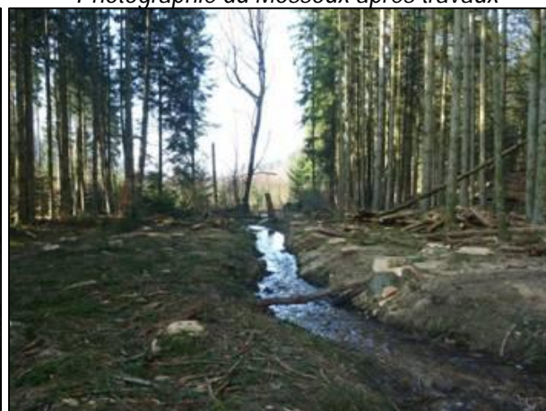
Photographie du Mossoux après travaux
