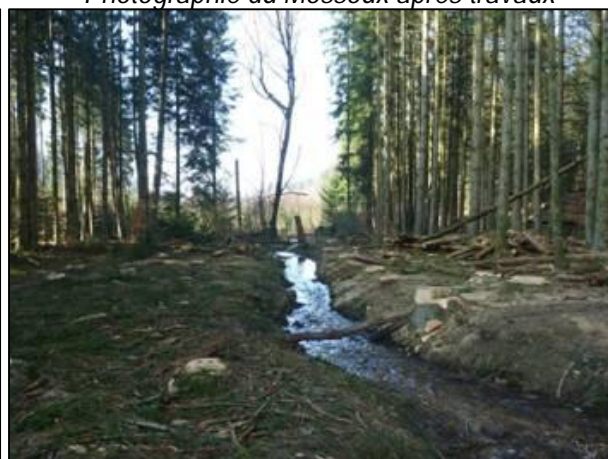
Photographie du Mossoux après travaux
