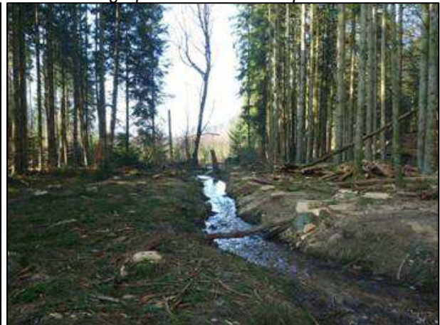
Photographie du Mossoux après travaux
