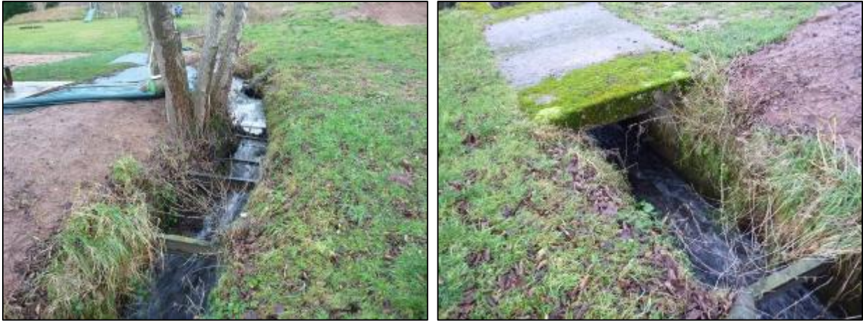
Lit de la Vacherie présentant une forte pente en amont immédiat de l'ouvrage
