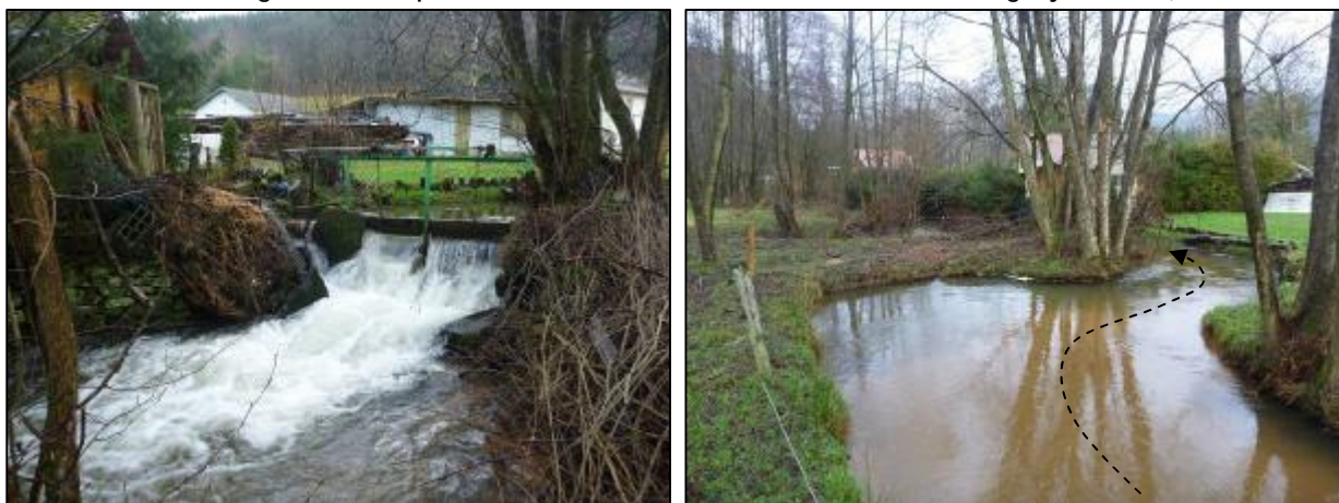
Vannage OH3 à l'Epine et Taintroué en amont immédiat d el'ouvrage (janv.2012)
