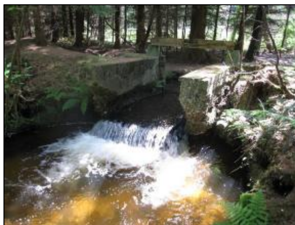
Aval de l'ouvrage
