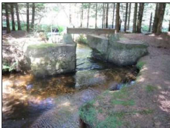
Amont de l'ouvrage
