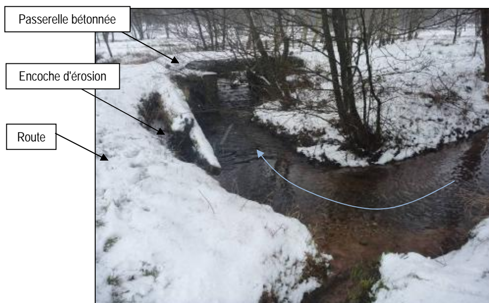
Encoche d'érosion du Neurain au bord de la route de Xainfeing – situation initiale (fin 2010)
