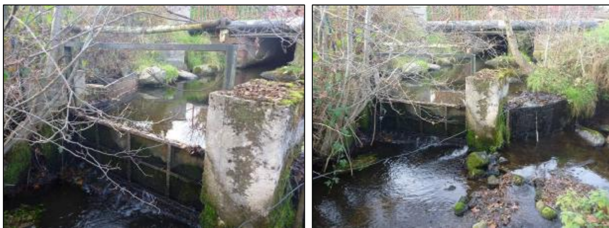
Aspect général de l'ouvrage (janv.2012)
