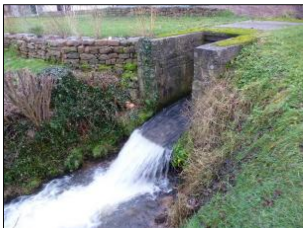
Coursier bétonné finissant par une chute de 75 cm
