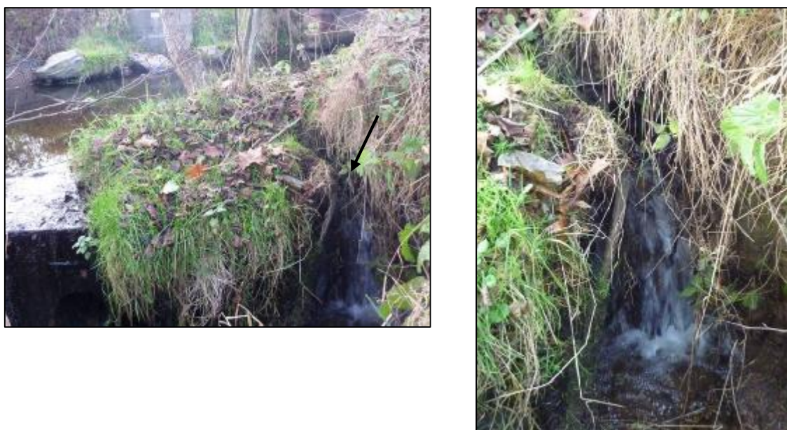
Infiltration qui contourne l'ouvrage en rive gauche
