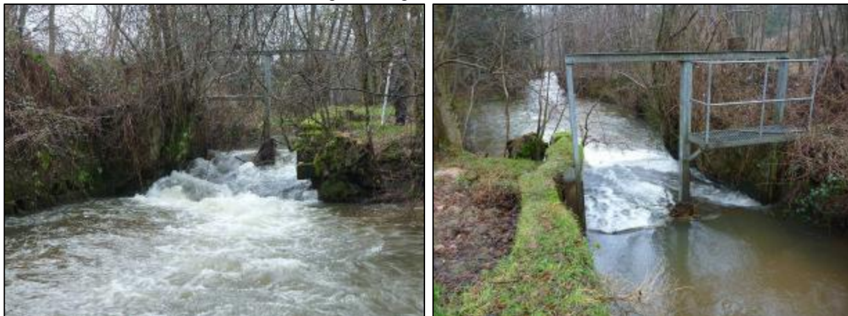
Ta-OH10 : Ancien vannage de La goutte des Mares (commune de Taintrux)
