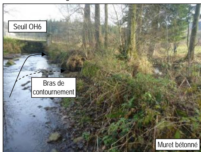
Valdange en amont immédiat du seuil
