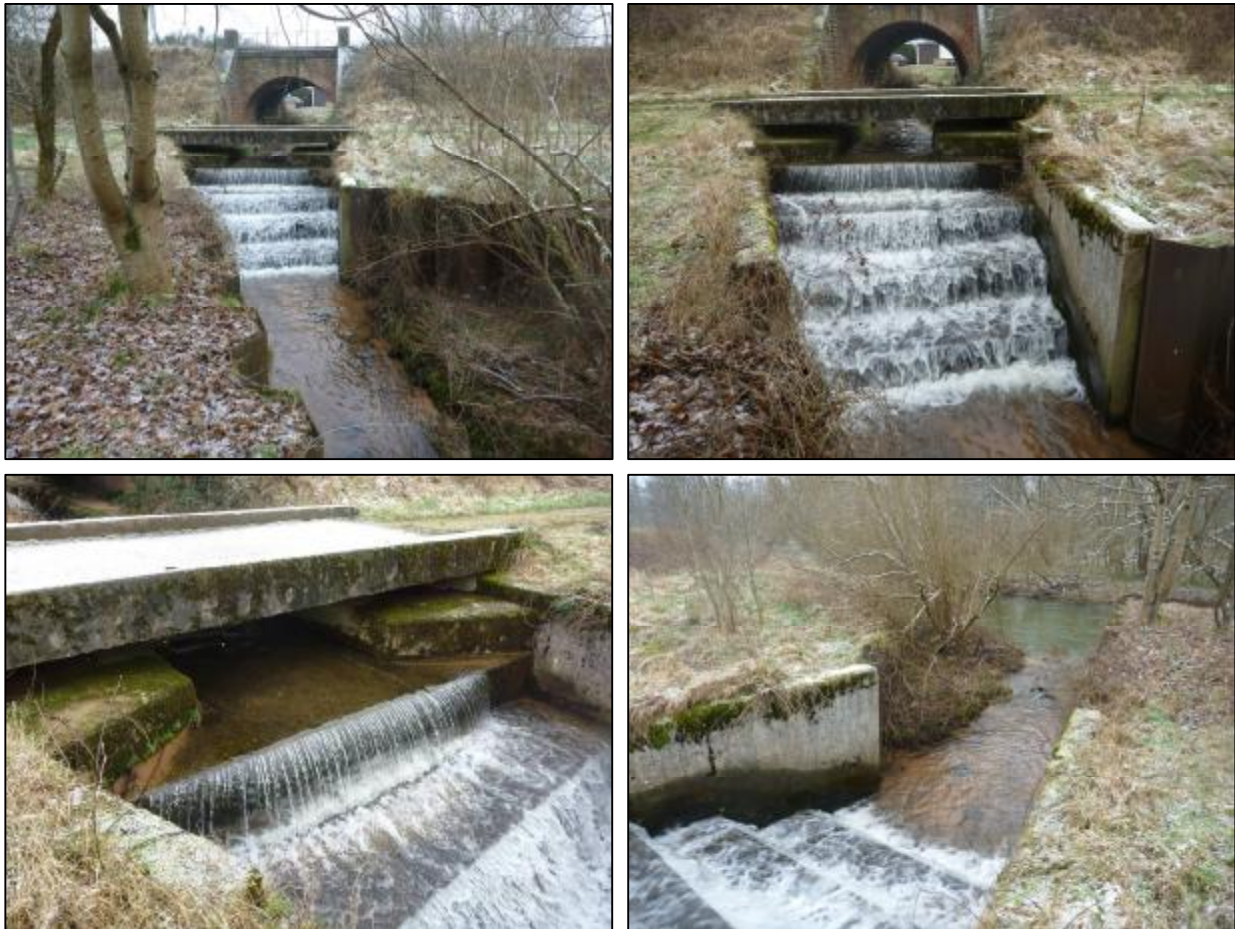
Ma-OH8 : chutes bétonnées à l'aval de la voie ferrée (janv.2012)
