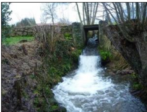
Coursier bétonné finissant par une chute de 75 cm
