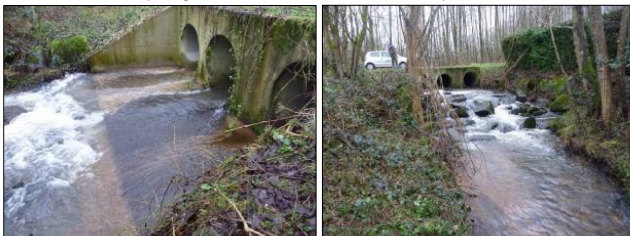
Vac-OH12 : passage busé suivi d'un radier béton et d'une rampe en enrochements
