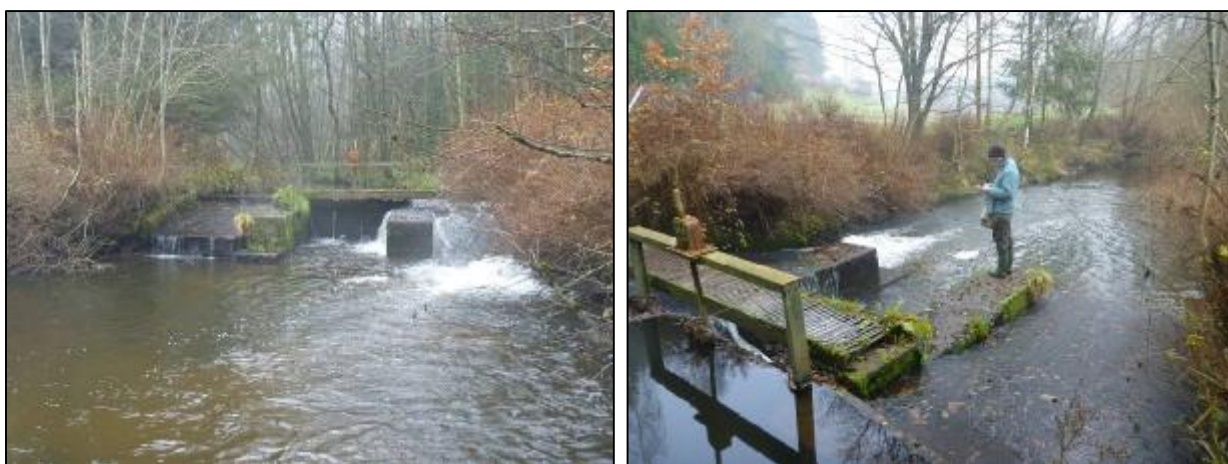
Vue générale de l'ouvrage de l'étang Delthir (janv.2012)
