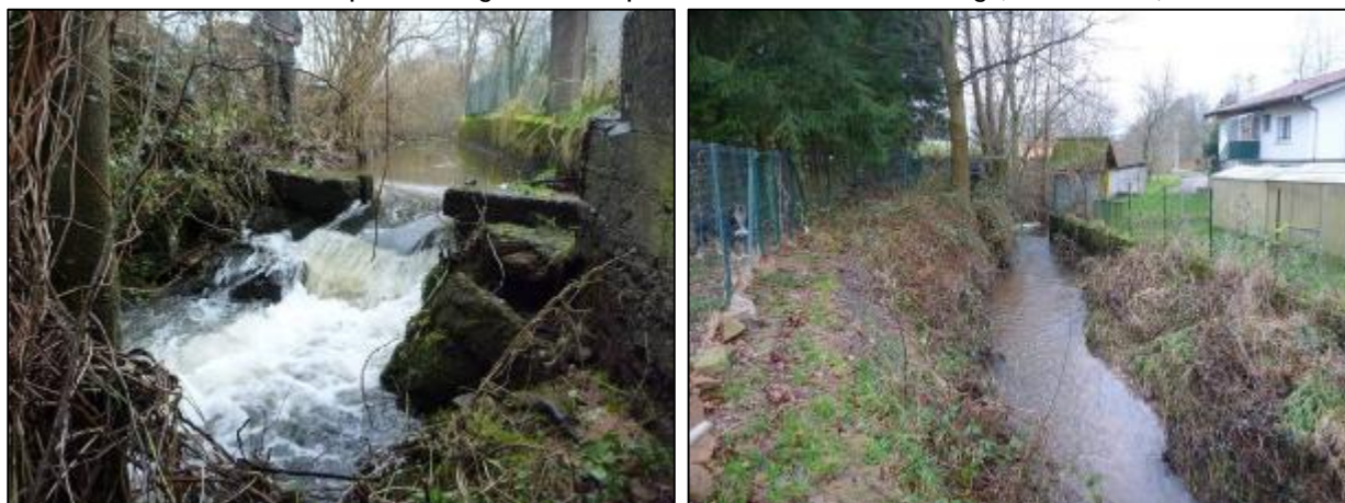
Vac-OH11 : petit barrage bétonné pour alimentation d'un étang (chute 60 cm)
