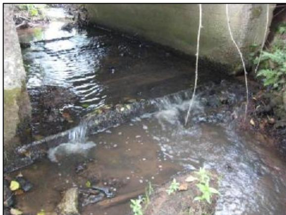
Il est proposé de réaliser un petit seuil aval, franchissable, en blocs d'enrochements, d'une hauteur de l'ordre de 20 cm, de manière à assurer un niveau d'eau suffisant au passage du radier de la passerelle.
