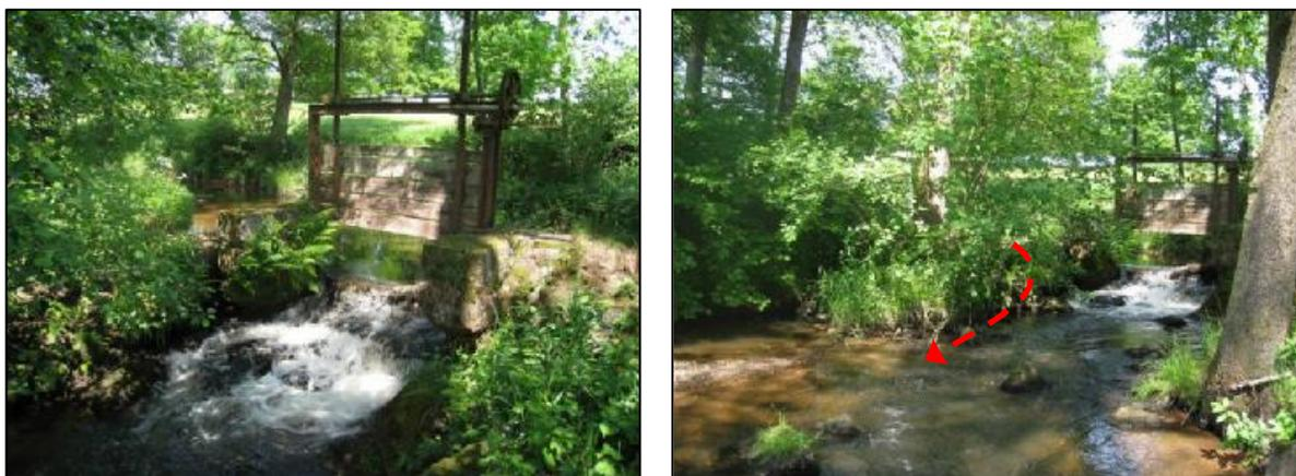
Il est proposé de contourner l'ouvrage en aménageant le bras de décharge pour faire passer l'ensemble de l'écoulement en rive droite et contourner ainsi l'ancien vannage (*flèche rouge sur la photo*). Cette solution correspond ainsi globalement à un effacement de l'ouvrage puisque l'ensemble du débit va passer dans le bras de contournement.
