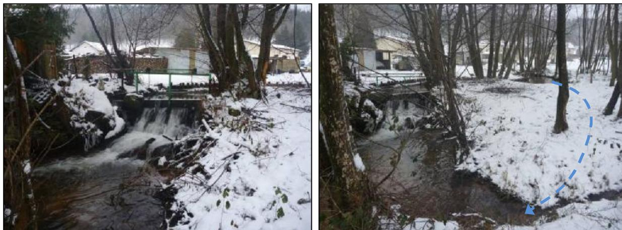
La configuration du site s'y prêtant parfaitement, il est proposé de réaliser un bras de contournement de l'ouvrage en rive gauche. Le bras pourrait notamment rejoindre le fossé présent en rive gauche à l'aval de l'ouvrage.
