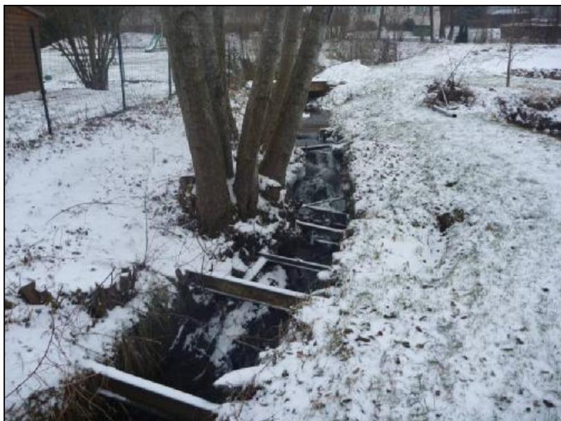
Ouvrage Va-OH6 : ce petit barrage est constitué de blocs empilés dans le lit du ruisseau pour maintenir un niveau d'eau suffisant à l'amont afin d'alimenter un étang privé. L'écoulement du ruisseau passe par infiltrations au travers du barrage. Cet ouvrage ne laisse passer ni les sédiments ni la faune piscicole.
