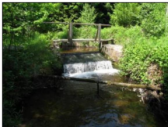
Il est proposé de réaliser deux seuils aval pour rehausser la lame d'eau de 50 cm à l'aval de l'ouvrage. Après aménagement il n'y aura plus de chute, les poissons devront franchir la partie supérieure du coursier sur un dénivelé de l'ordre de 20 à 30 cm.
