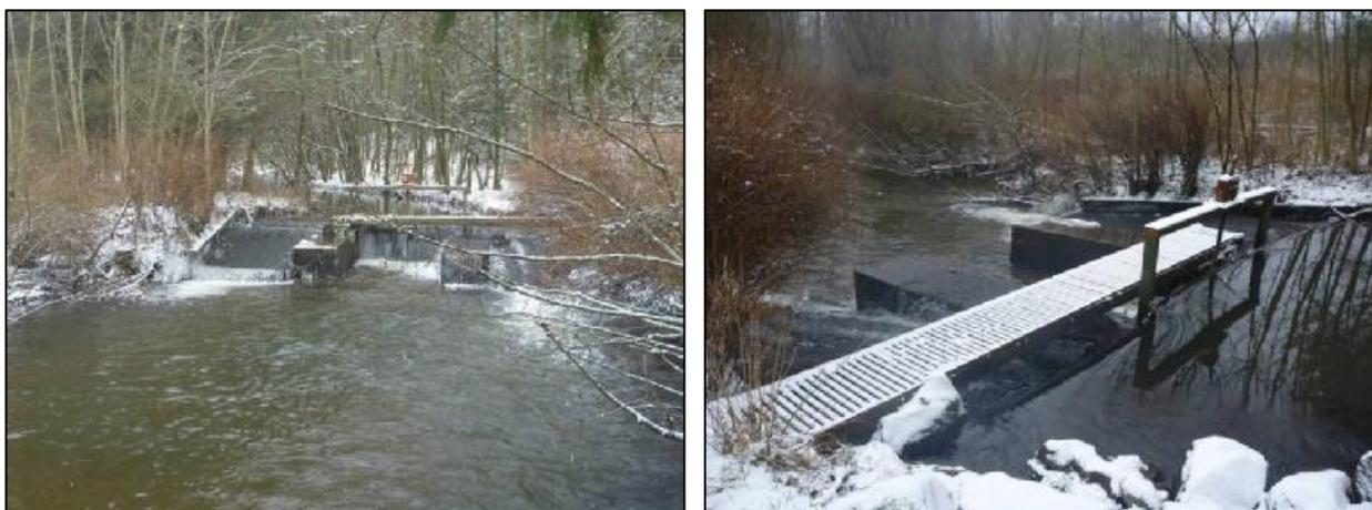
La solution technique proposée pour cet ouvrage est l'aménagement du coursier en rive gauche sous forme d'une rampe en enrochements. Le coursier sera garni de blocs répartis de manière à assurer le franchissement piscicole (Salmonidés).
