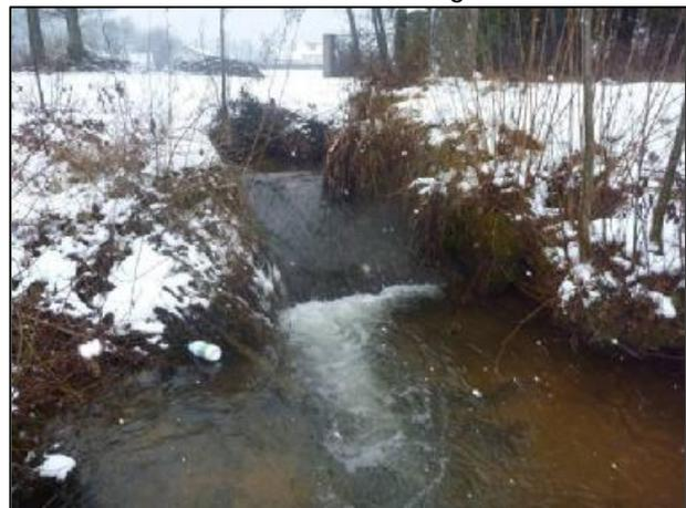
Il est proposé de réaliser un seuil aval, en aval de la restitution du bras de décharge, pour rehausser le niveau d'eau de 25 cm et permettre ainsi aux poissons de remonter vers l'amont de l'ouvrage. Le seuil sera accompagné d'une échancrure dans le coursier bétonné du seuil latéral de 10 cm de haut sur 1 m de large.
