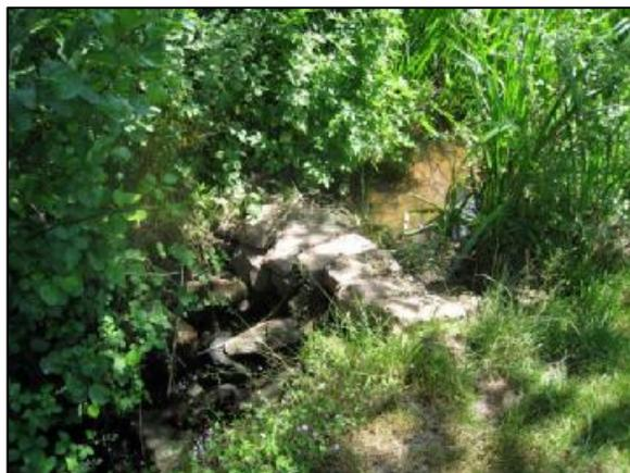
Ouvrage Va-OH7 : cet ancien coursier bétonné est long de 3 m. A l'aval immédiat de l'ouvrage le lit est fortement incisé, il en résulte une chute de 70 à 80 cm. Cet ouvrage est infranchissable pour les poissons.
