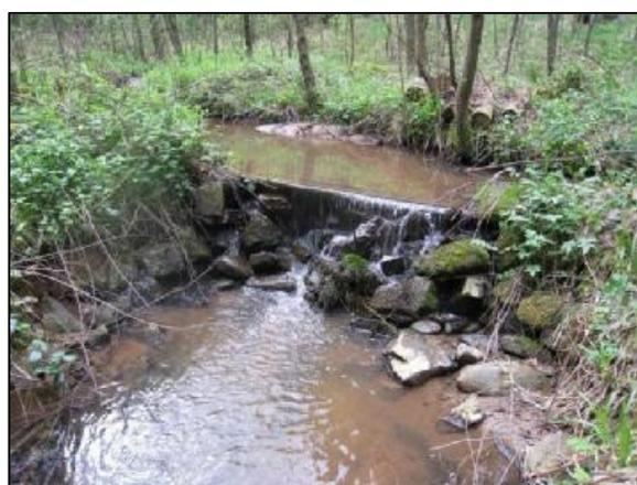
Il est proposé de réaliser une échancrure dans le seuil existant et de mettre en place 2 seuils aval : le premier de 40 cm de haut, suivi d'un second de 20 cm de haut. Cela permettra de fractionner la chute actuelle de 60 cm en 3 chutes franchissables de 20 cm, rendant ainsi cet ouvrage franchissable.
