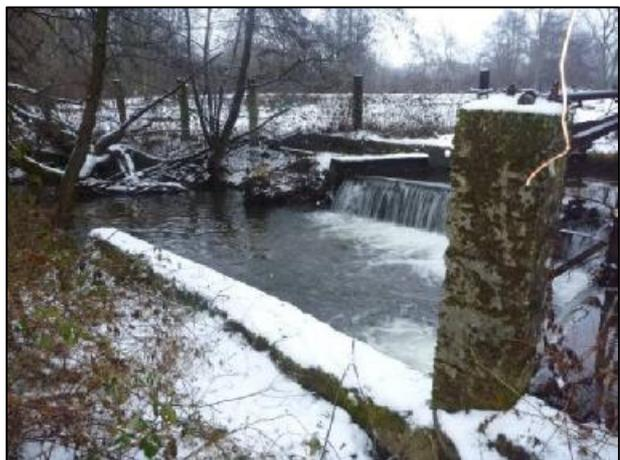
Il est proposé de réaliser une passe à poissons bétonnée, constituée de 3 pré-barrages formant une succession de 4 chutes de 25 cm.
