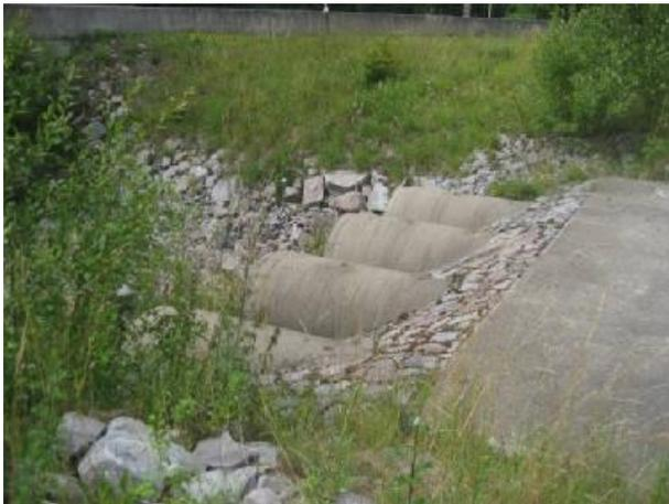
Vue de l'ouvrage écreteur constitué de 4 buses de diamètre 1000 mm et d'une surverse (23/06/2011).
