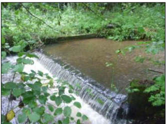
15) Seuil pour alimentation des plan d'eau en rive droite
