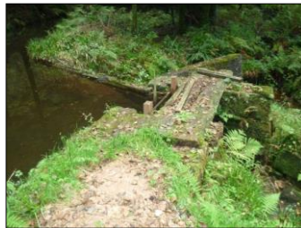
12) Vue sur le barrage
