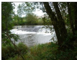
5) Vue du barrage, octobre 2013
