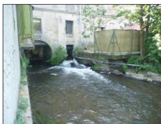
2) Moulin vue de l'aval
