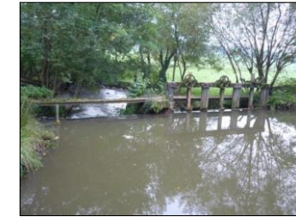
2) Vue du barrage depuis l'amont
