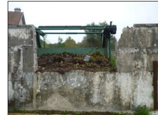
6) Derrière de la grille
