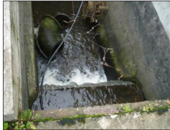
2) Seuil et trou d'évacuation
