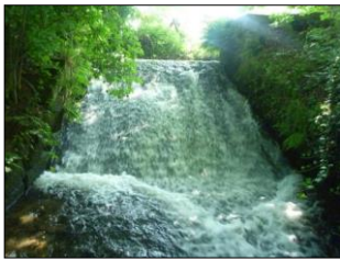
3) Radier en béton, vue de face
