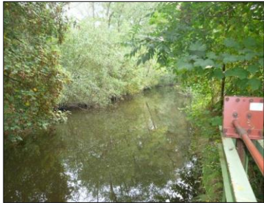
1) Vue vers l'amont depuis la vanne
