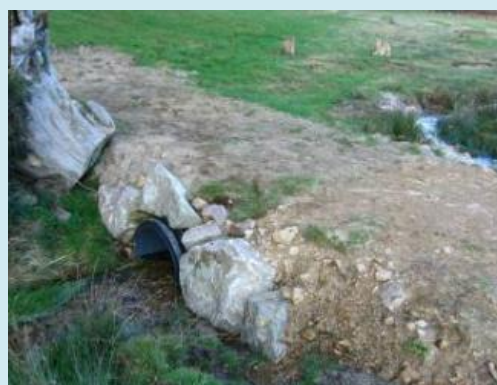
Photographie de mise en place de demi buse PEHD
