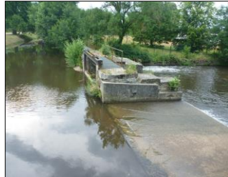
2) Barrage avec vannage et déversoir en amont de l'école
