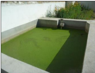
7) Bassin avec vanne
