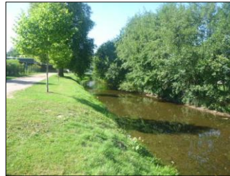
4) Vue vers l'aval du canal de la Mortagne
