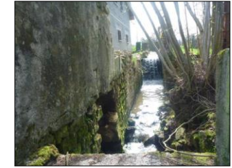
2) Seuil depuis l'aval
