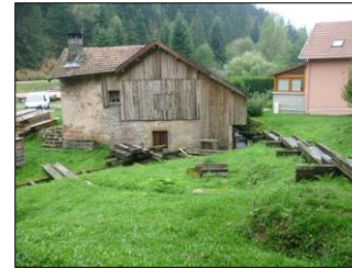
3) Vue sur la scierie depuis l'amont
