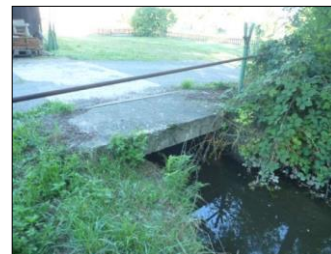
7) Pont sur le bief
