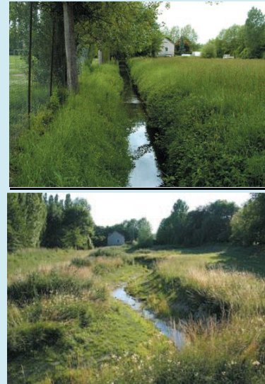
Photographie du reméandrage du ruisseau de Marolles (avant et après travaux) (Source : M. Bramard ONEMA 2012)
