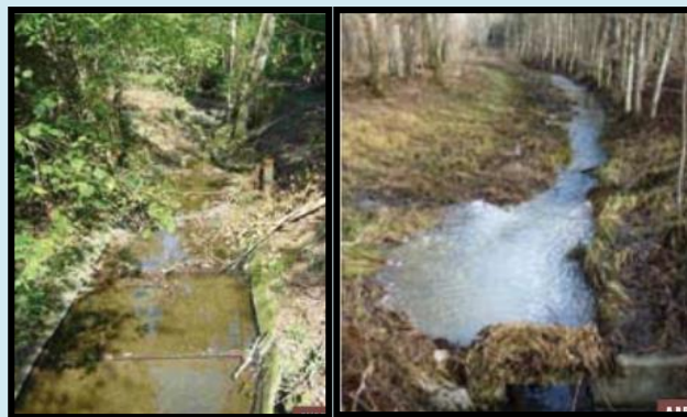
Photographie de suppression de protection de berges obsolètes (avant et après) (Source : Canton de Genève, 2012)
