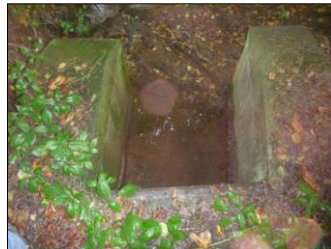
10) Bras de décharge
