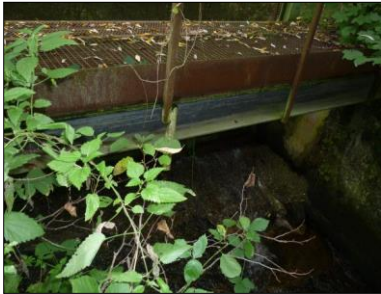
3) Vanne sous passerelle
