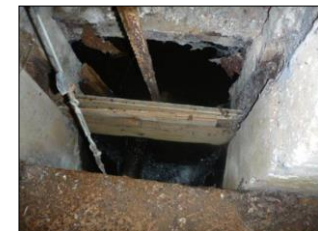
2) Vannage dans la poterie
