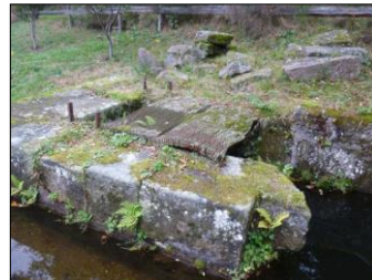
10) Début du passage souterrain
