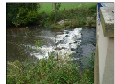
4) Enrochement et radier de pont
