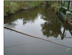
1) Vue vers l'amont, depuis le pont
