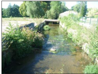
6) Vue vers aval depuis la passerelle
