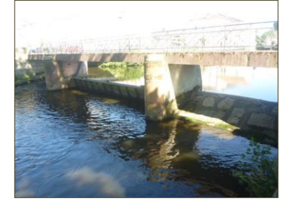
1) Barrage, vue depuis l'aval
