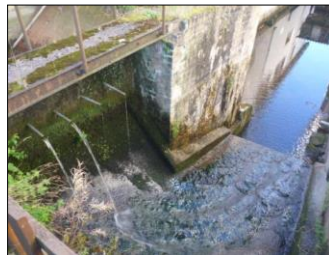
4) Rejet d'eau sur le déversoir
