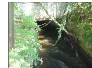
8) Vue vers amont (ancien vannage) du canal ouvert
