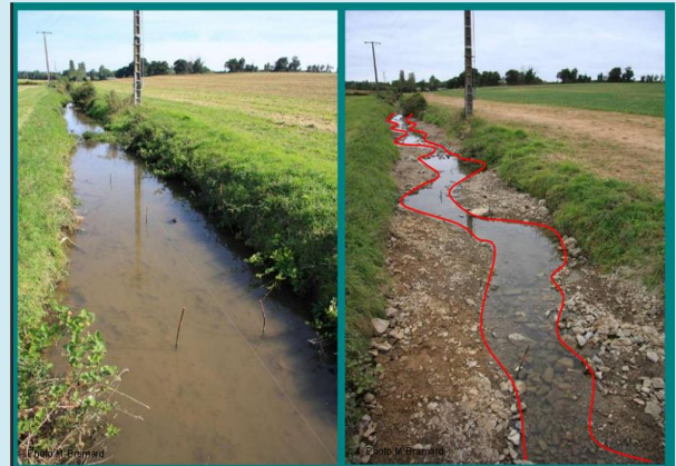
Photographie d'une recharge granulométrique dans un petit cours d'eau de plaine (avant et après travaux) (Source : ONEMA Bramard M., 2012)
