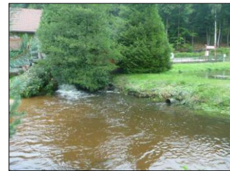
6) Exutoire du plan d'eau et bras de décharge
