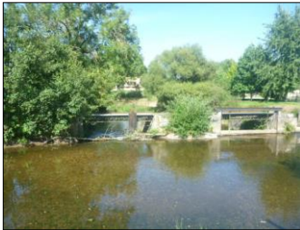
3) Vannage du barrage en amont du déversoir
