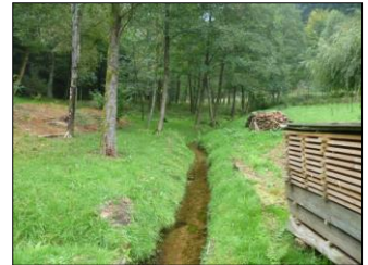
6) Vue vers amont du bras de décharge
