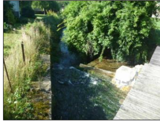
1) Vue depuis la passerelle du déversoir
