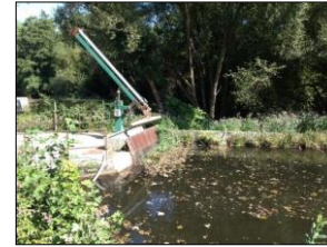
1) Grille avant prise d'eau pour la turbine
