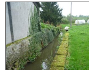
7) Vue vers aval du canal sortant de la forge
