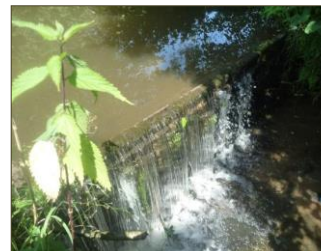
8) Seuil du bras de décharge
