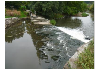
2) Déversoir à enrochement liaisonné
