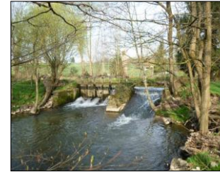
1) Vue du barrage depuis l'aval
