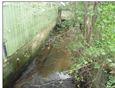
4) Vue vers aval du bief depuis la vanne
