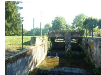
6) Vannage du barrage de l'école
