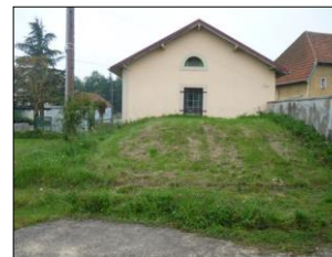
7) Bâtiment abritant la turbine
