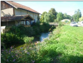
5) Vue vers aval
