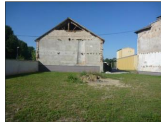
8) Usine avec le bief souterrain
