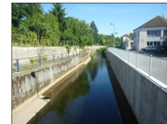
8) Vue vers l'amont de la Mortagne
