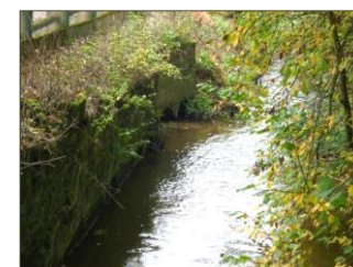
2) Sortie double buse du canal de la turbine
