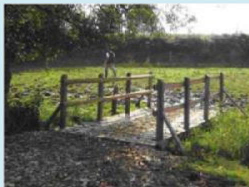
Photographie de mise en place de passerelle
