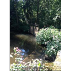
8) Second vannage, 300m en amont de la turbine
