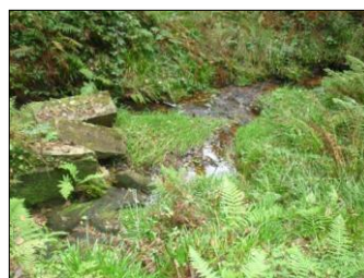
16) Vue en aval du barrage sur le bief
