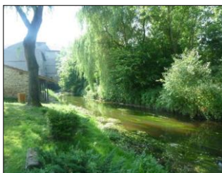
1) Vue générale depuis l'aval avec le lavoir
