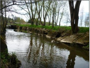
6) Barrage avec consolidation des berges
