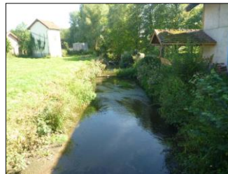
4) Vue vers amont depuis la passerelle
