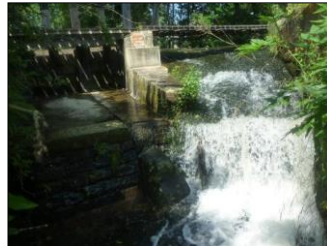
2) Barrage (vannage et déversoir)
