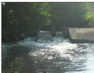
6) Vanne du barrage
