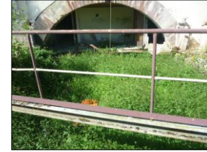
4) Canal qui passe sous l'ancienne papeterie, mur bloquant les écoulements
