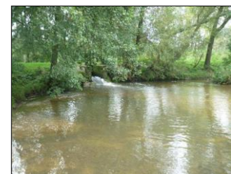
6) Vue du barrage depuis la zone d'affouillement
