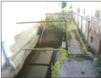
3) Grille en amont du déversoir
