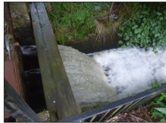
4) Vanne avec chute de 1m
