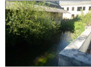
2) Vue vers aval en amont de l'ancienne papeterie
