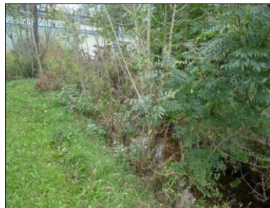
5) Vue vers l'amont du bief depuis le pont
