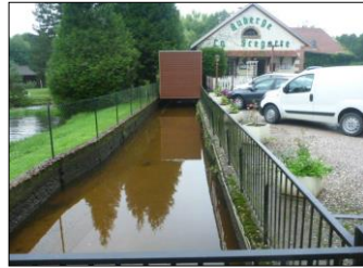
2) Vue vers la turbine
