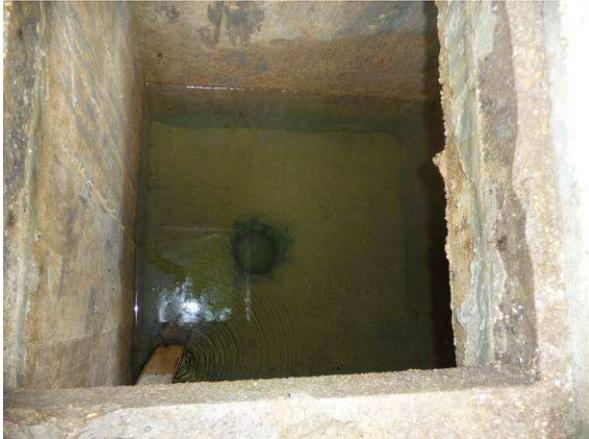
\*Percement du fond réalisé suite au tarissement afin d'essayer de retrouver la source. Sans effet, l'eau dans le regard provenant probablement d'infiltrations en période pluvieuse.
