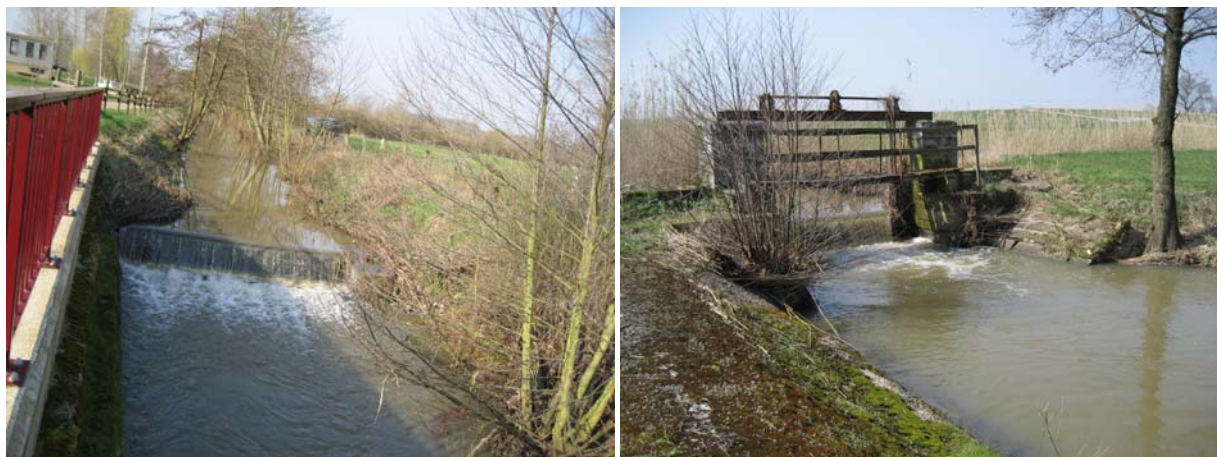
Photos 11 : Seuil à Torcheville (à aménager) et premier seuil à Albestroff à supprimer
