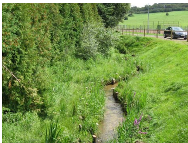
Photos 3 : Reconstitution d'un lit mineur (Avant/Après) le Billeron (57) chantier SOGREAH 2006
