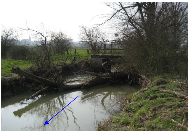
Photo 3 : Ancien pont sur l'ancien méandre de l'Albe à supprimer
