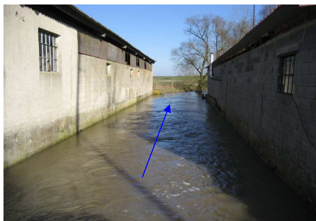
Photo 4 : Canal du moulin au droit du Moulin Bas
