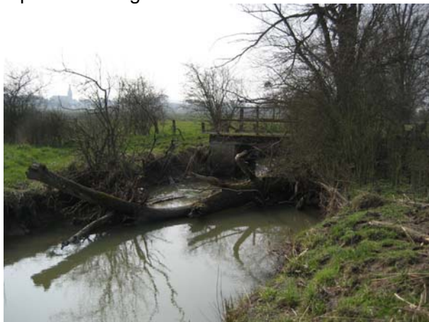
Photos 39 : Exemple d'ouvrages dans l'Albe à Rening et à Sarralbe
