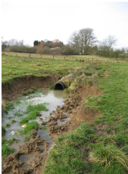
Photo 38 : Buse dans le lit du Buschbach
