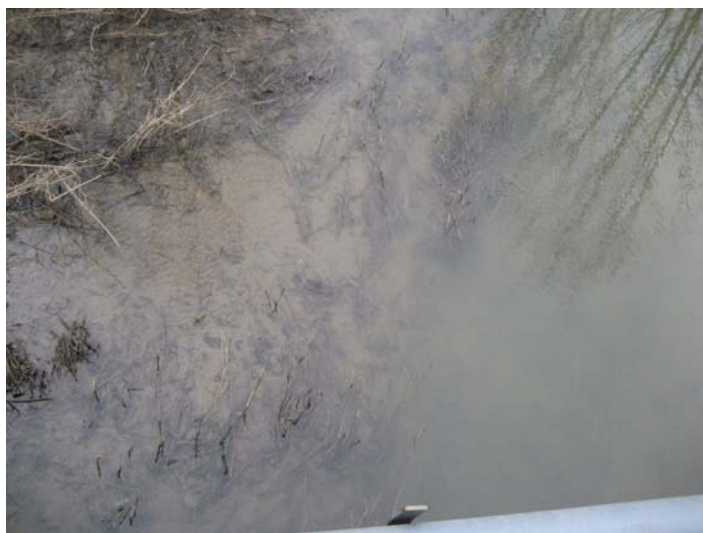
Photo 28 : Exemple d'atterrissement au droit du pont de Munster sur la Rose
