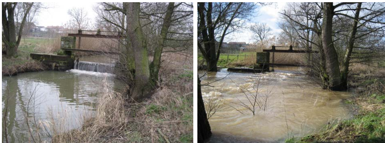
Photos 1 : Ouvrage de Munster (1.2m de hauteur de chute) le 31 janvier 2007 et le 15 février 2007 (noyé)
