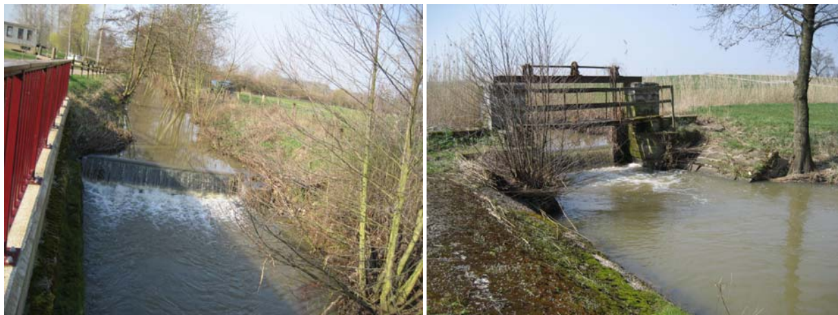
Photos 34 : Seuil à Torcheville et premier seuil à Albestroff
