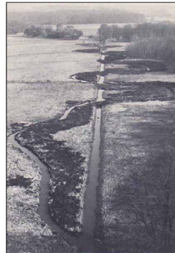
Vue à la fin des travaux en février 1982 (Giltz, 1983). Niveau d'ambition R3.
