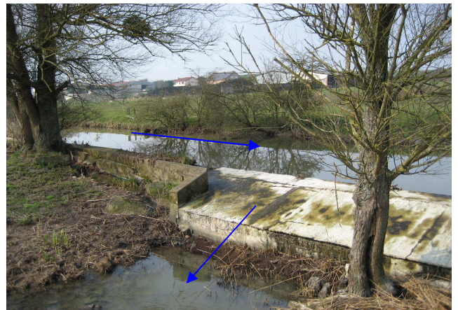
Photo 4 : Ouvrage de décharge au droit du Moulin (canal se jettant dans l'ancien bras)
