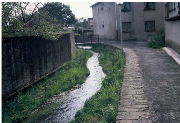
Photo 10 : Aménagement après travaux ruisseau Montvaux (source AERM)
