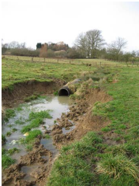
Photo 32 : Aménagement d'un passage à gué sur le Buschbach
