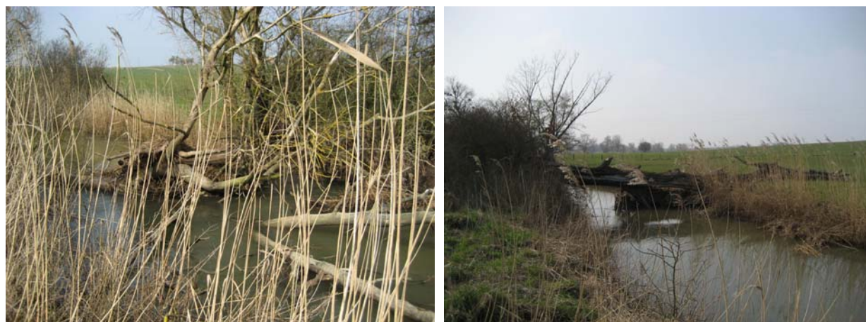
Photos 26 : Exemple d'embâcles sur l'Albe à Kappelkinger
