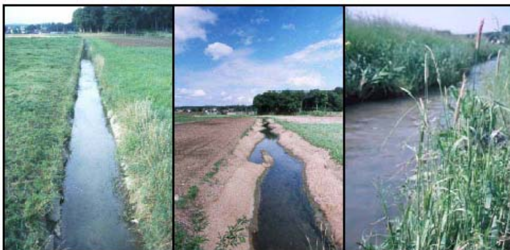
Photos 12 : Exemple d'aménagements par déblais-remblai sur le Vendline (Jura) - source Agence de l'eau Rhône méditerranée Corse
