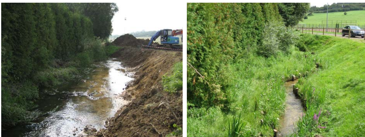
Figure 14 : Reconstitution d'un lit mineur (Avant/Après) – le Billeron (57) –chantier SOGREAH 2006
