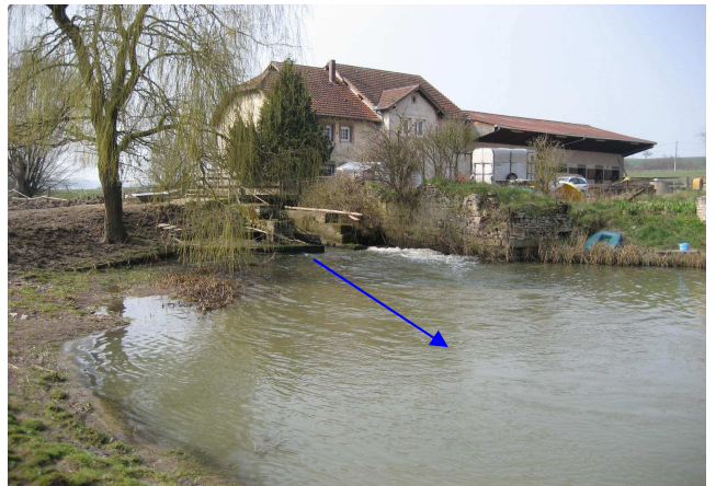
Photo 6 : Ouvrage au droit du Moulin Haut
