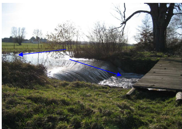
Photo 2 : Au niveau de la dérivation et du seuil canal de trop plein
