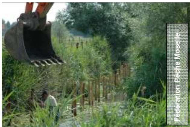
Mise en place de banquettes (2006)
