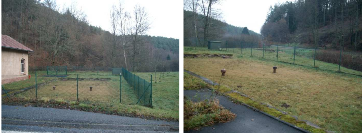
Figure 13: Photographies de la bache de reprise d'eau traitée
