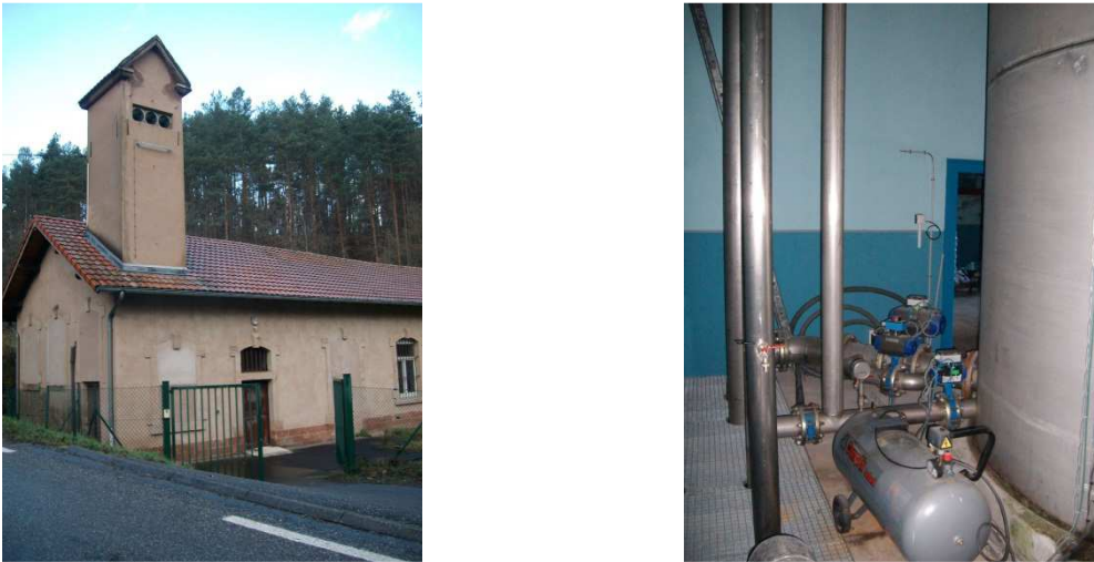
Figure 10: Photographies de la station de traitement
