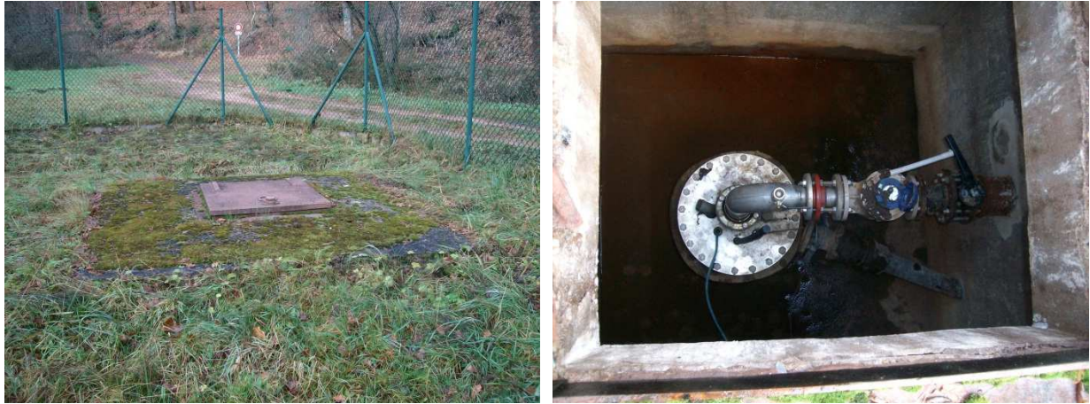
Figure 5: Photographies du forage du "Moulin d'Althorn"
