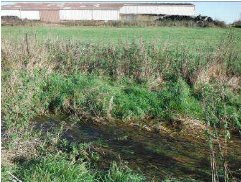
Photo 4 : envahissement du chenal d'écoulement par des hélrophytes et berge effondrée en rive gauche
