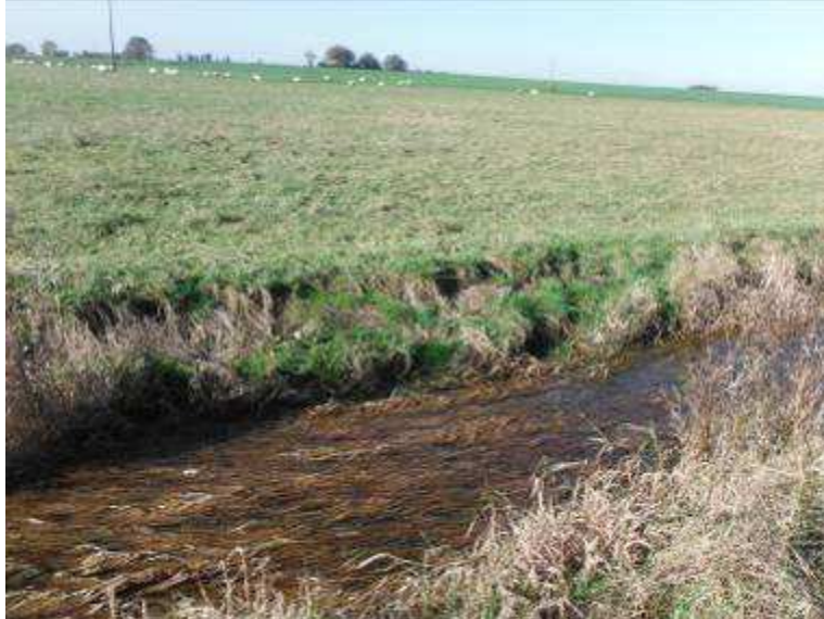
Photo 5 : berge en rive droite effondrées
