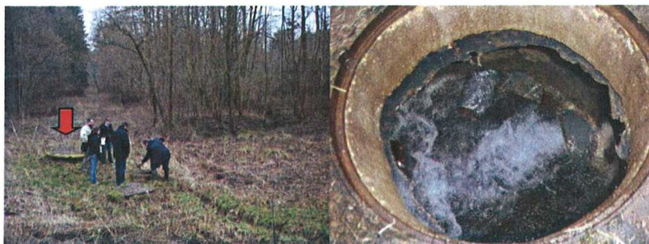
On note 3 arrivées au total (les 2 batteries + 1 collecteur) et 2 départs (1 trop plein vers le ruisseau et 1 vers la cabine de rassemblement des eaux).
