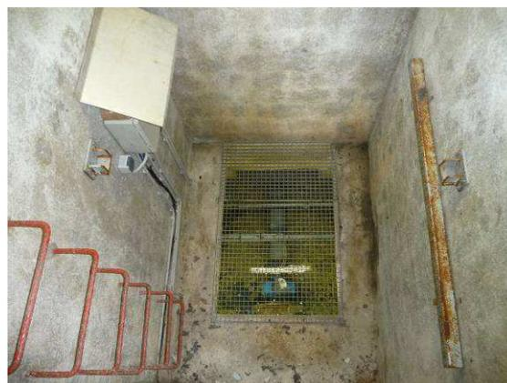
Bâtiment captant équipé d'un débitmètre (en amont des ouvrages CACM)
