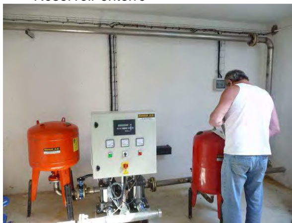
Arrivée depuis le réservoir bas
