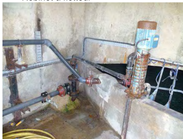
Départ vers Chagny Haut (raccordement sur ancien refoulement pompe et installation électrique Hors service)
