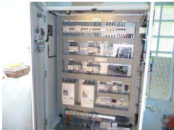
Les installations d'électricité
