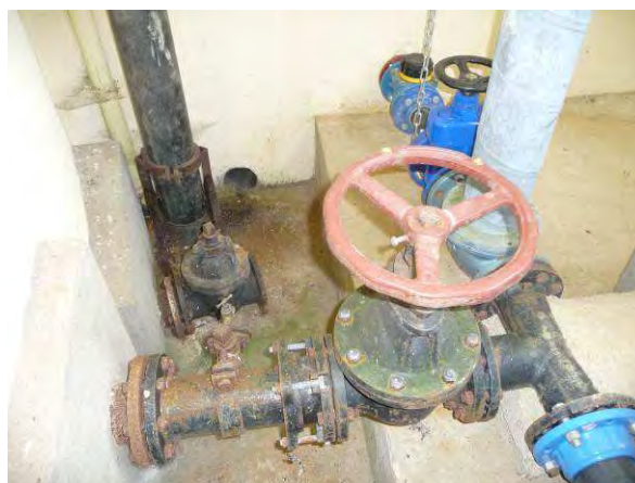
Alimentation vers Marquigny
