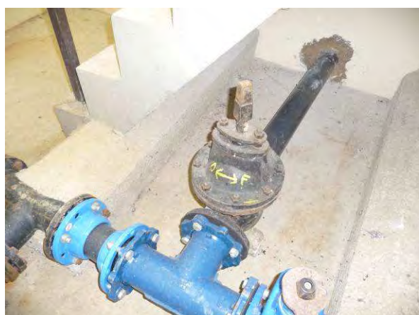
Départ vers la bouche incendie
