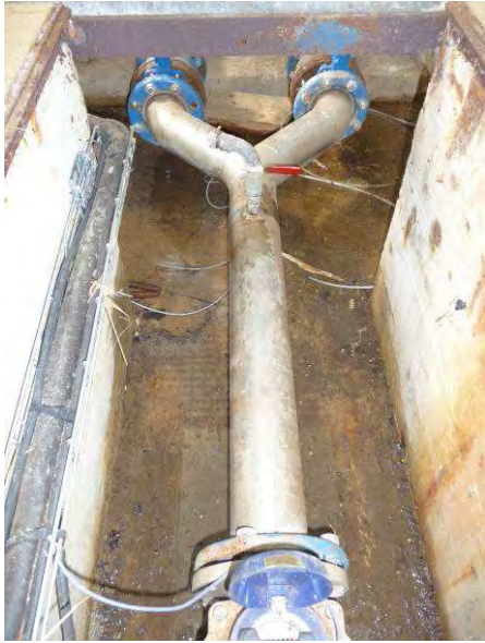
Le ballon anti béliet et la canalisation de refoulement
