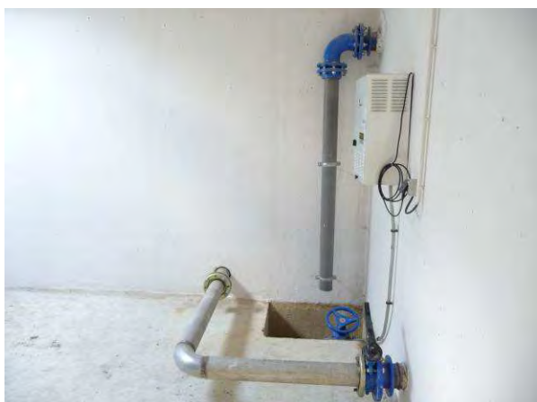
Trop plein et liaison vers la réserve incendie
