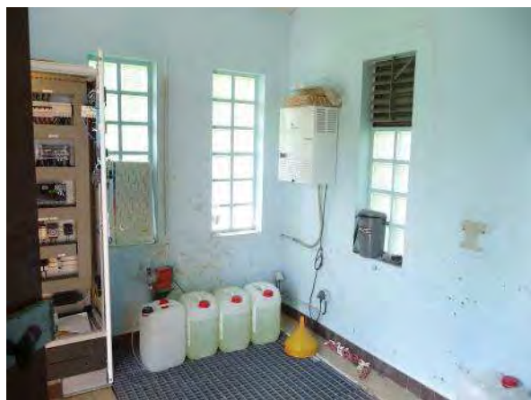
L'injection de chlore
