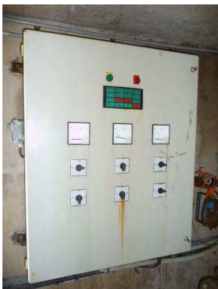
Armoire de commande
