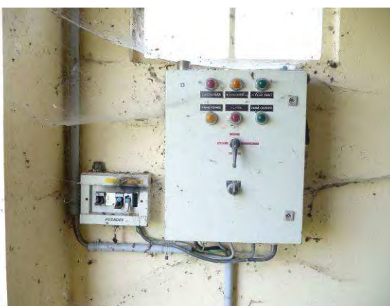
Installation électrique (non utilisée)
