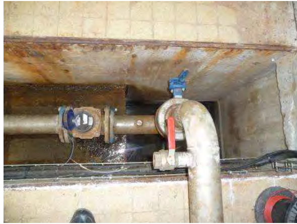
Le ballon anti béliet et la canalisation de refoulement
