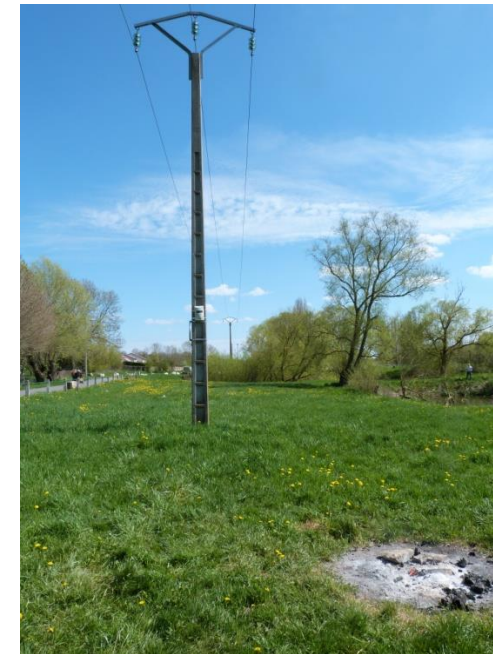
Photo 11 : Détail du poteau électrique implanté sur la berge en partie nord-est de l'étang (23/04/2013)
