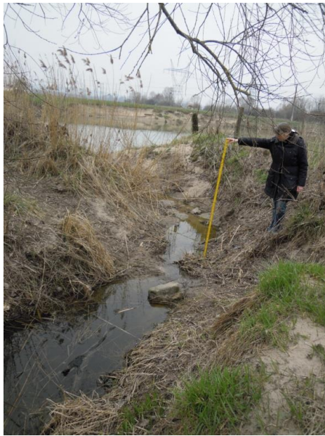
Photo 3 : Vue générale du chenal de connexion entre l'étang des Croquottes et la Meurthe (27/03/2013)
