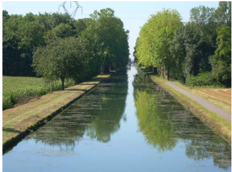
Le canal du Rhône au Rhin à Nordhouse (photo RID 67 - août 2012)
