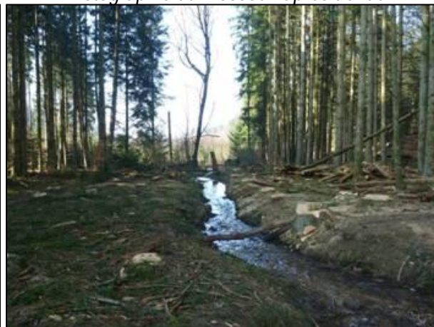
Photographie du Mossoux après travaux
