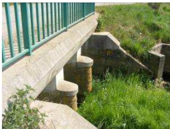
Ouvrage impactant avec piliers de béton dans le lit mineur mais permettant une réduction du lit mineur propice.
