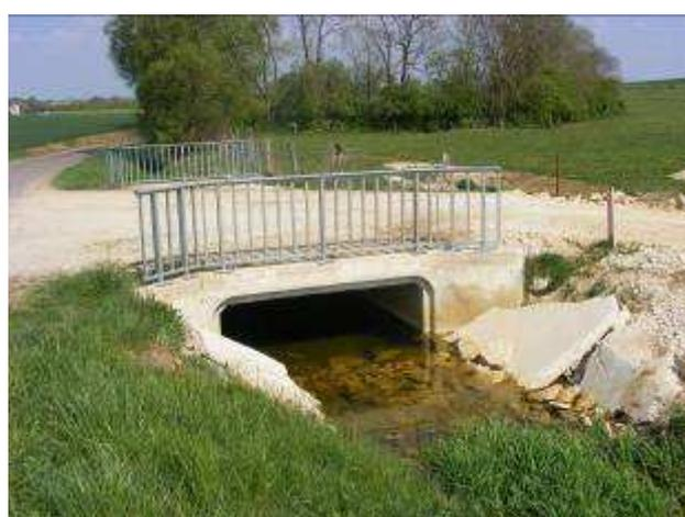
Ouvrage neuf remplaçant une buse, la hauteur laisse peu de marges en cas de crue.
