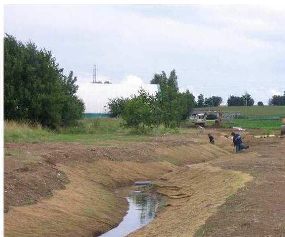
**Photo 4** : pose de géotextile (source : AERM)
