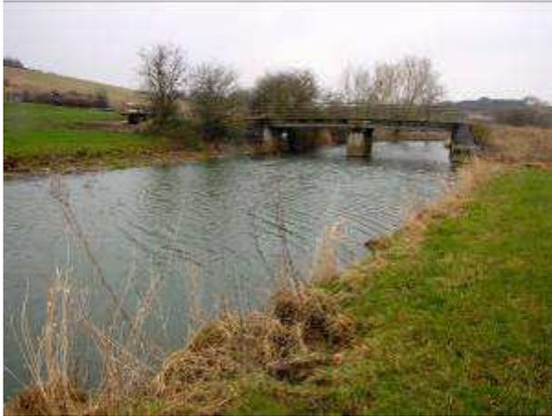
Le second pont, plus à l'amont permet le passage d'un chemin agricole. La pile centrale n'a *a priori* que peu d'impact sur l'Othain, puisqu'aucune sédimentation n'a été observée. Une étude plus poussée aiderait à déterminer si cet ouvrage a un impact sur l'écoulement de l'Othain et sur le transport solide du ruisseau.
