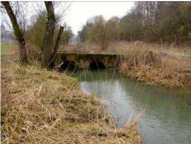
Une passerelle busée permet le passage d'engins agricoles. Ce dernier est imposant compte-tenu de la faible largeur du ruisseau. Le niveau d'eau élevé au moment de la visite ne permet pas d'évaluer clairement l'impact sur l'écoulement des eaux et la sédimentation au niveau de cet ouvrage. Une étude en période d'étiage permettra de mieux juger cet impact.
