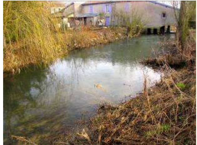
Photographie 3-30 : Vue aval du moulin
