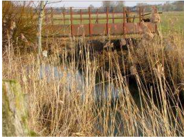
Photographie 3-18 : Passerelle à l'aval du tronçon Spi 4 – vu de l'amont vers l'aval
