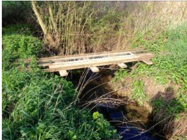
Photographie 2-1 : Passerelle à l'aval du ruisseau du Puget
