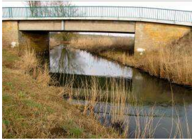
Photographie 3-7 : Pont de la RD 16
