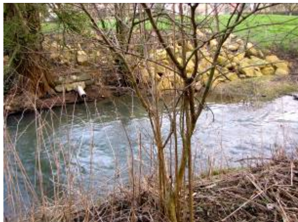
Photographie 3-37 : Rejet et enrochement sur la rive droite – Tronçon Spi 8
