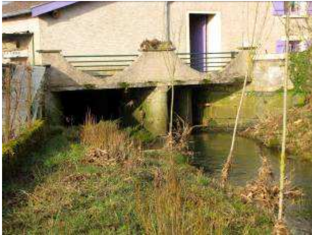
Photographie 3-29 : Vue amont du moulin
