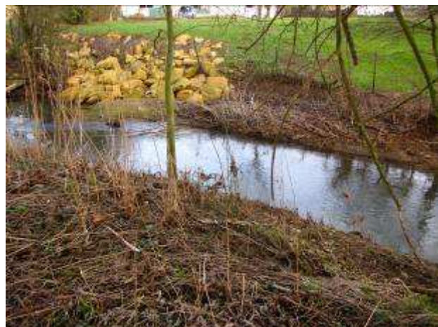
Photographie 2-2 : Enrochement des berges - Spincourt
