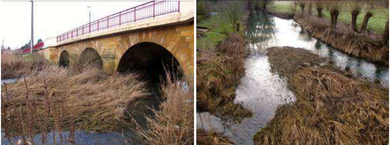
Photographie 3-41 et Photographie 3-42 : Pont de la RD 18 – Zone de sédimentation amont
