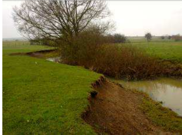
Photographie 3-29 : Affaissement des berges rive gauche
