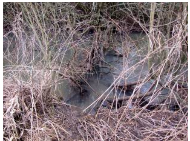
Photographie 3-14 : Embâcle – Tronçon Man 3
