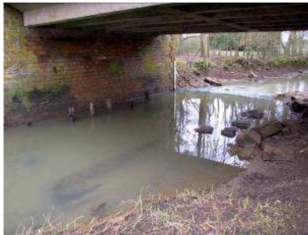
Photographie 3-18 : Le Loison sous le pont de la RD66
