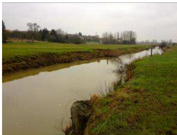
Photographie 1-2 : Le Loison au droit du rejet de la station de traitement de Mangiennes
