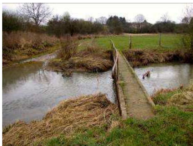
Photographie 3-12 : Passerelle à l'aval du gué
