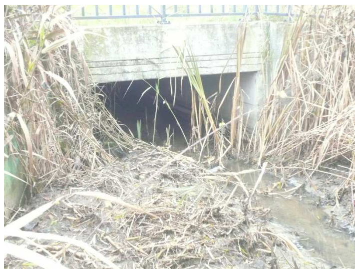
Sortie du pont-cadre
