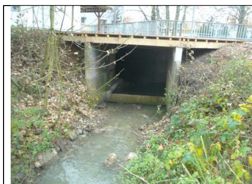
début du tronçon : sortie du pont cadre
