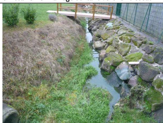
enrochement aux abords du carrefour
