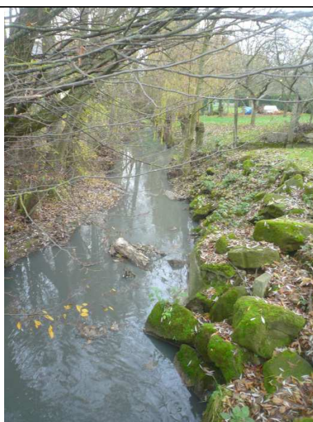
enrochements déstabilisés
