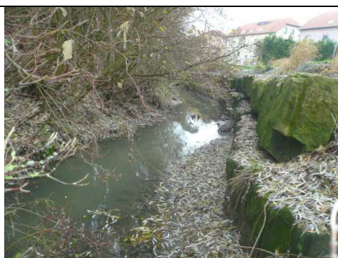
confortements avec des pare-chocs + pneus en rive gauche
