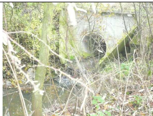
sortie de la buse côté aval
