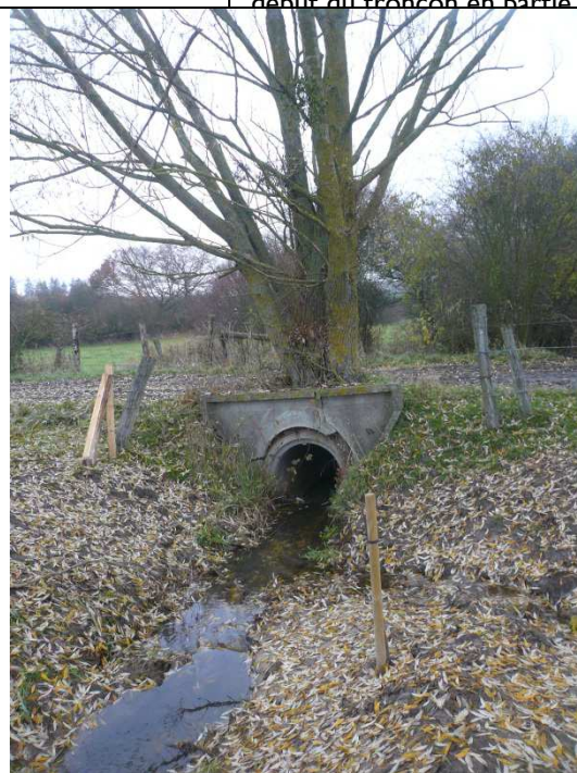
entrée de la buse coté amont
