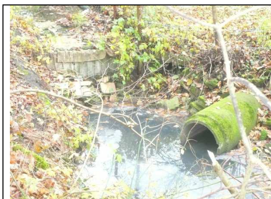
Rejet d'étang en remblai
