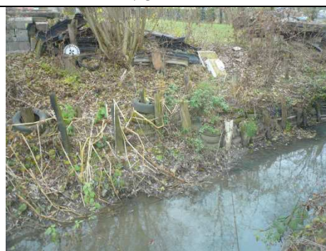
confortements avec pneus empilés en rive gauche
