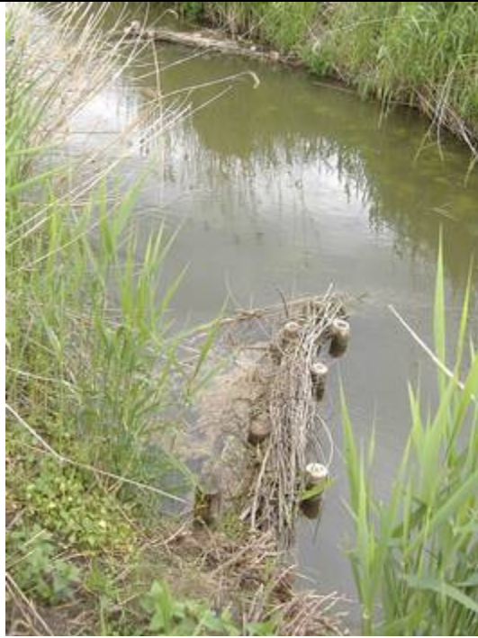
Epis en fascines implantés sur l'Albe (57)
