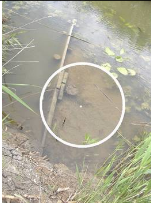
Epis en planche implantés sur l'Albe (57). A noter le comblement progressif à l'aval de l'aménagement. Les retours positifs sur la qualité du compartiment biologique (IBGN) sont observés dès quelques mois, suite aux travaux de diversification
